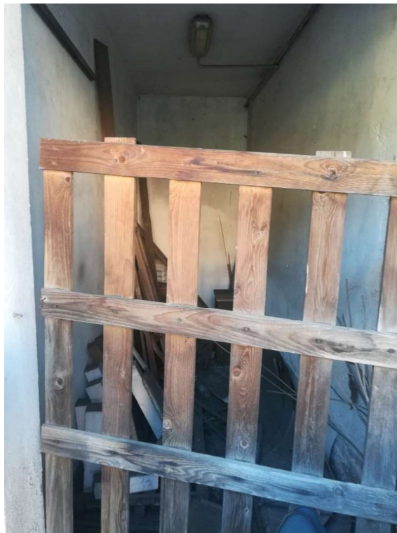
Figura 10 - Cantina mappale 1225 sub. 4
