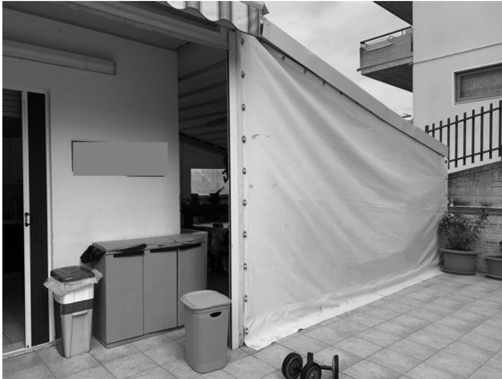
Fotografia G.7 - PIANO PRIMO - Terrazzo
