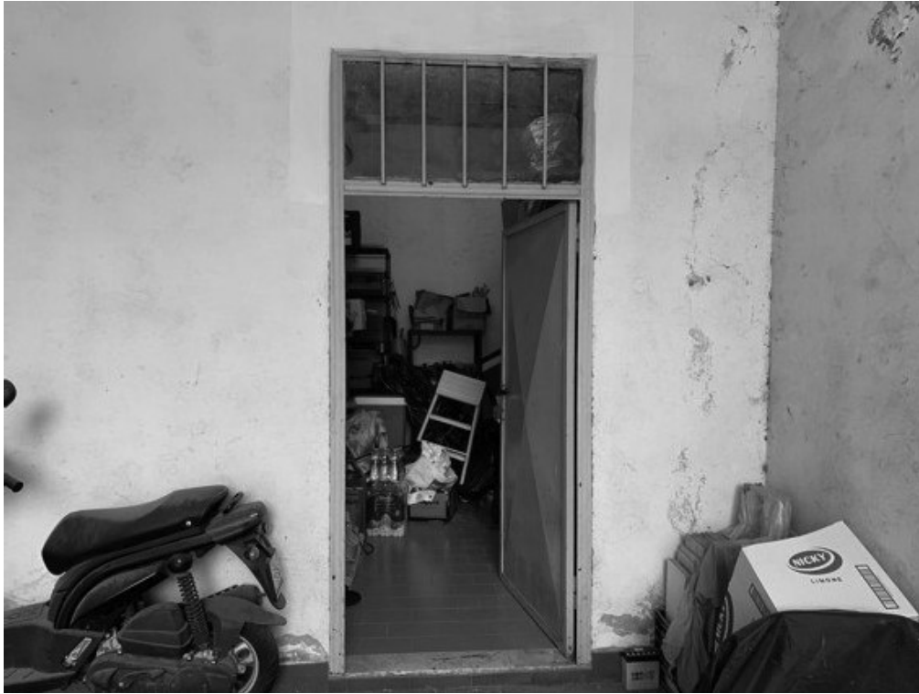
Fotografia G.31 - PIANO TERRA - Ingresso fondaco
