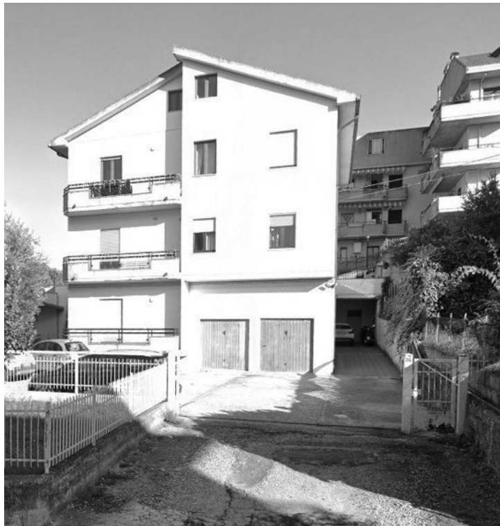
Fotografia G.1 - PROSPETTO OVEST
