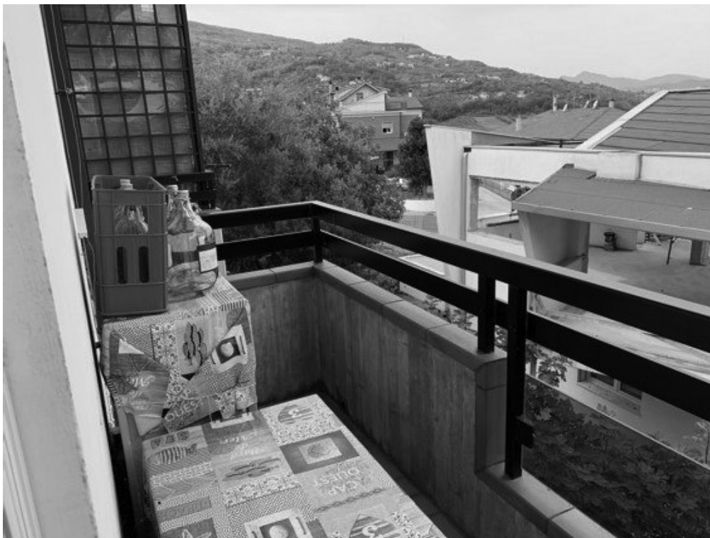
Fotografia G.16 - PIANO PRIMO - Balcone lato Nord
