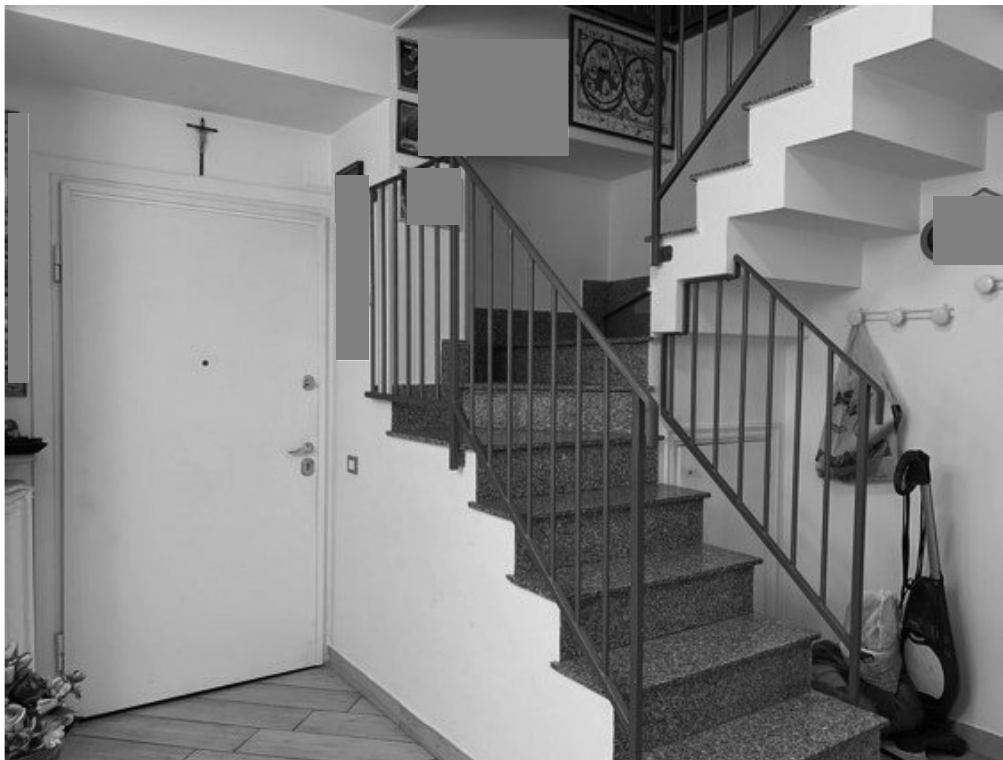
Fotografia G.3 - PIANO PRIMO - Scala Interna
