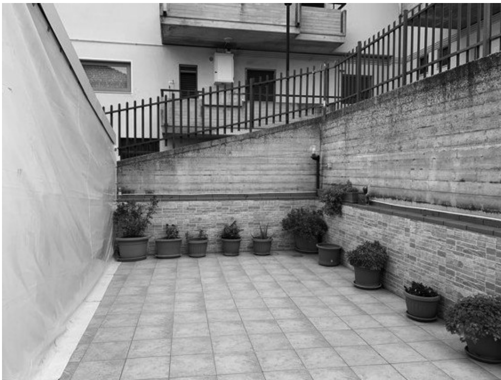
Fotografia G.8 - PIANO PRIMO - Terrazzo
