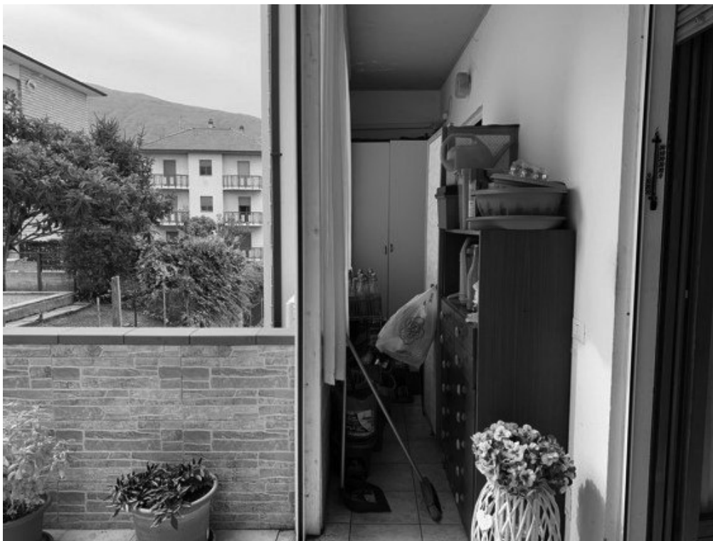
Fotografia G.10 - PIANO PRIMO - Terrazzo
