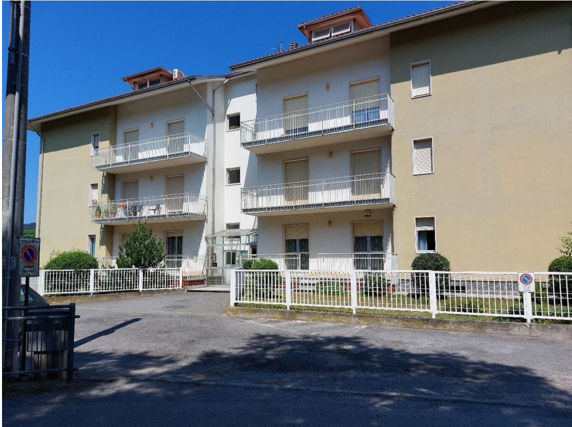
Foto 1_vista "prospetto principale condominio Oasi"
