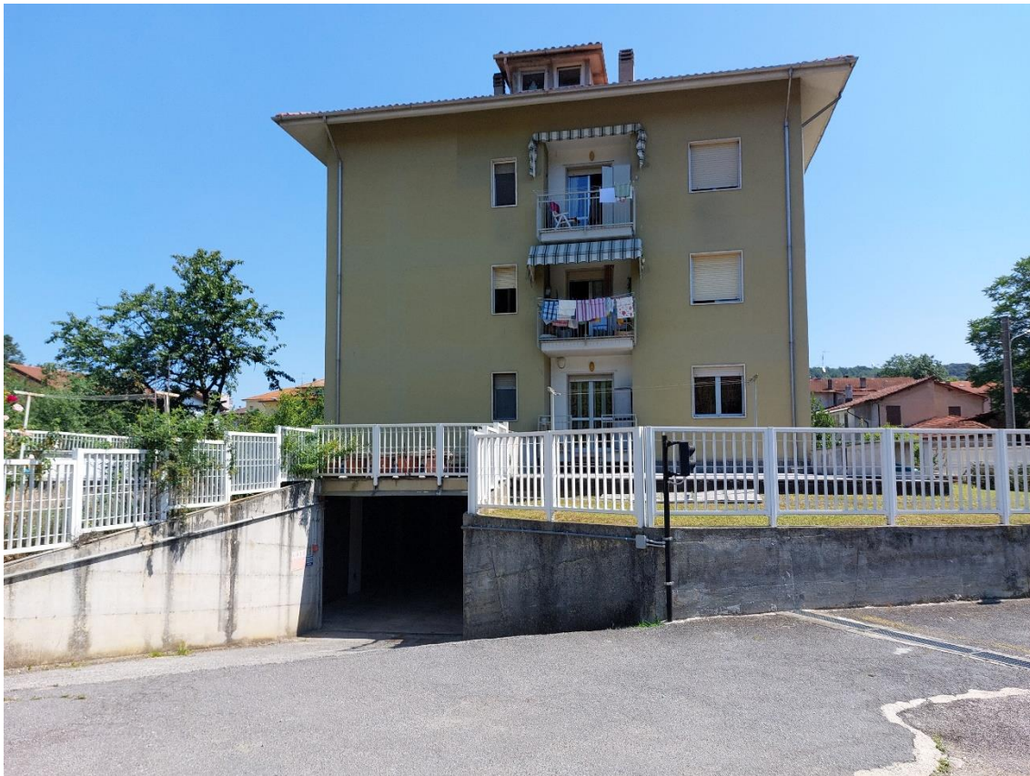
Foto 2_vista "ingresso autorimessa al piano interrato"
