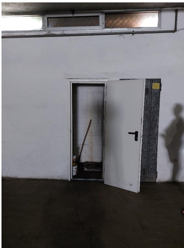
Foto 14_ porta di accesso alla cantina
