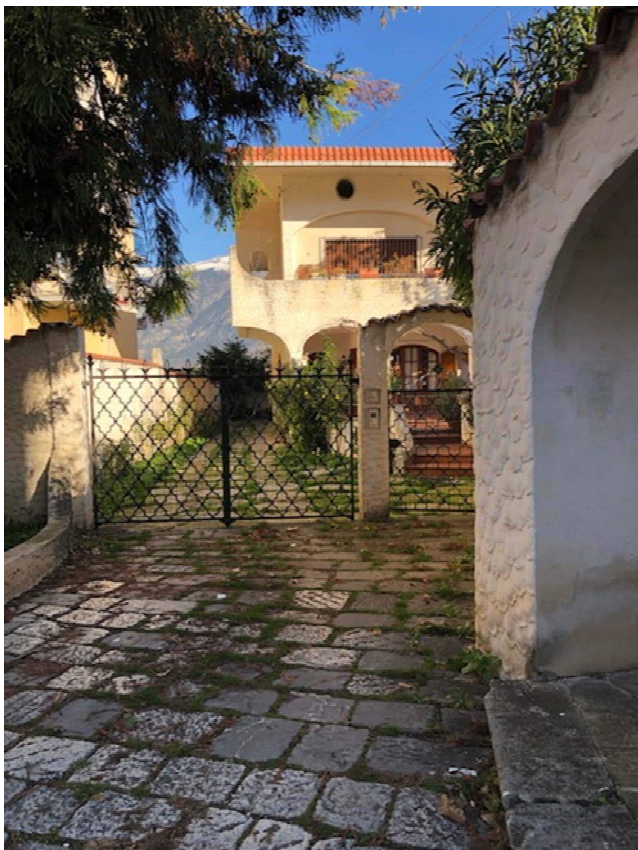
ingresso carrabile e pedonale da via Montenero n.53
