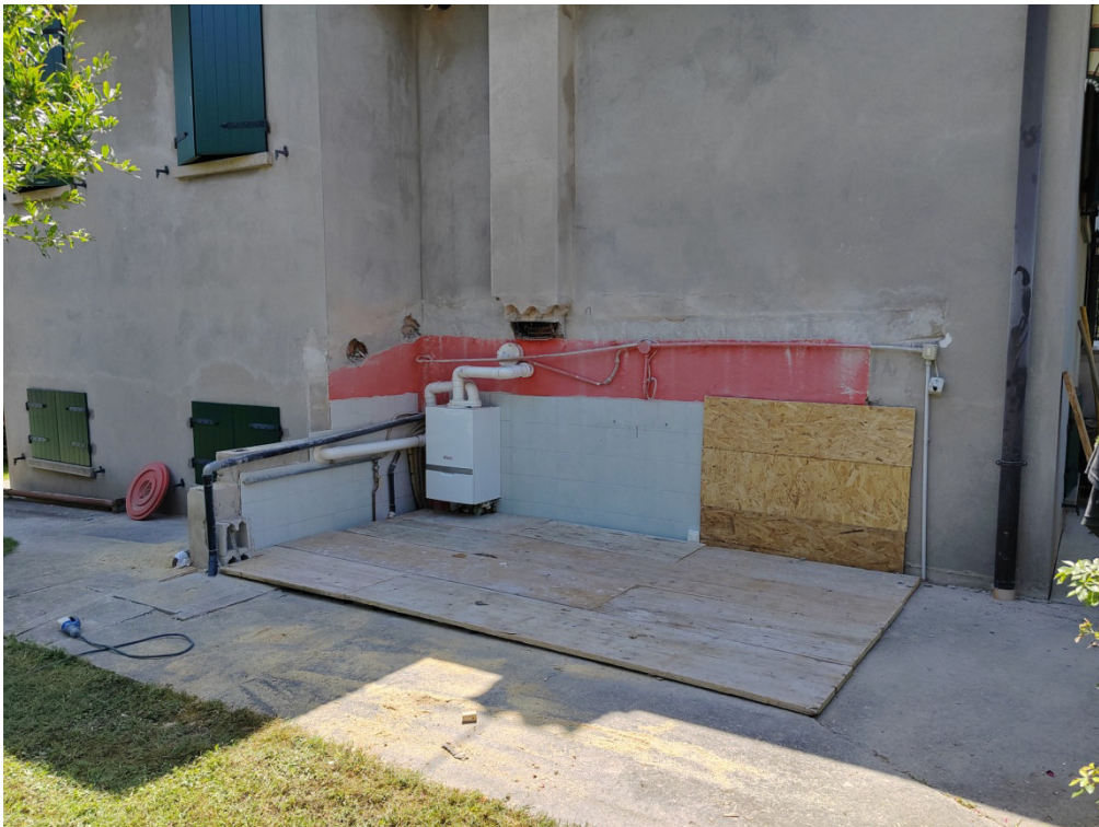
FOTO 2 – Demolizione completa dell'accessorio e ripristino dello stato originario dei luoghi
