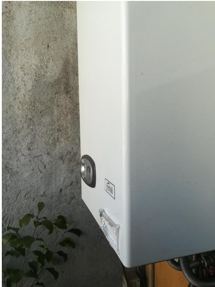
CLADAIA APPARTAMENTO FOGLIO 66 part.43 sub.27
