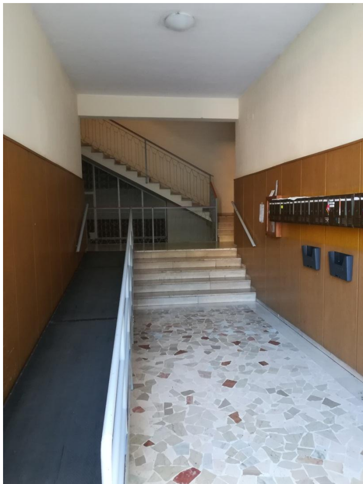
INGRESSO CONDOMINIALE APPARTAMENTO FOGLIO 66 part.43 sub.27
