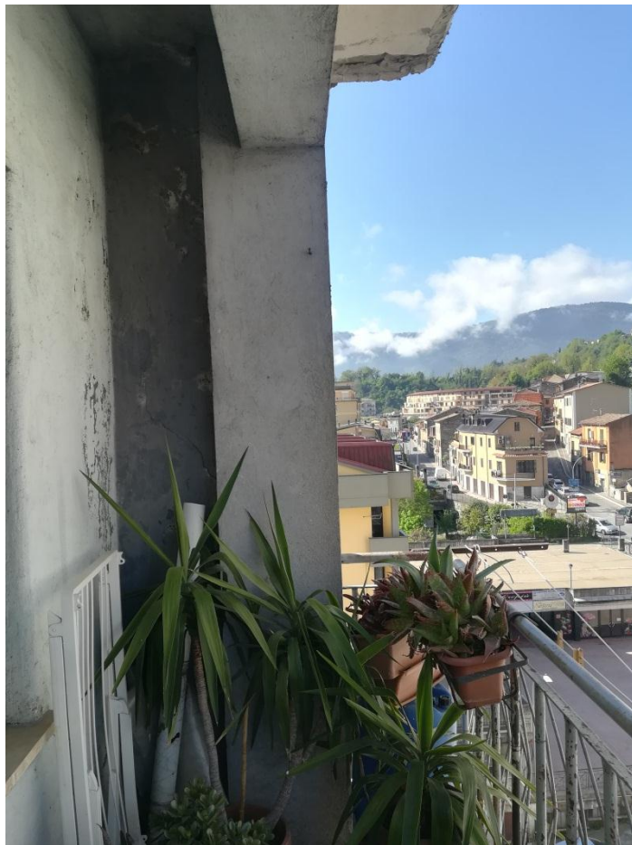
BALCONE N°1 APPARTAMENTO FOGLIO 66 part.43 sub.27
