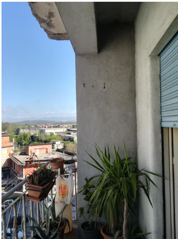
BALCONE N°1 APPARTAMENTO FOGLIO 66 part.43 sub.27
