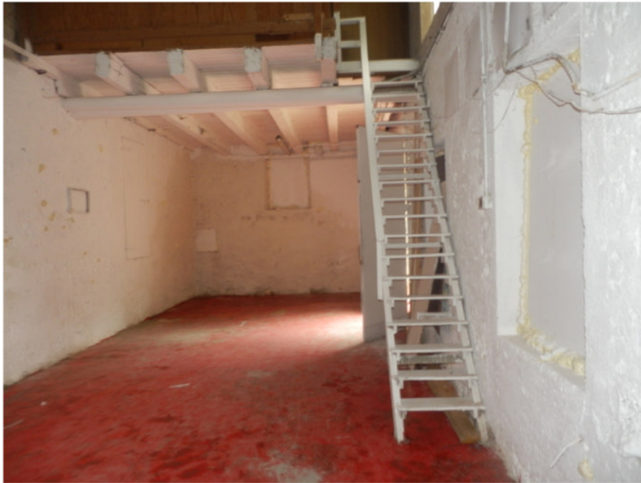
23 vista interna del magazzino2 PT
