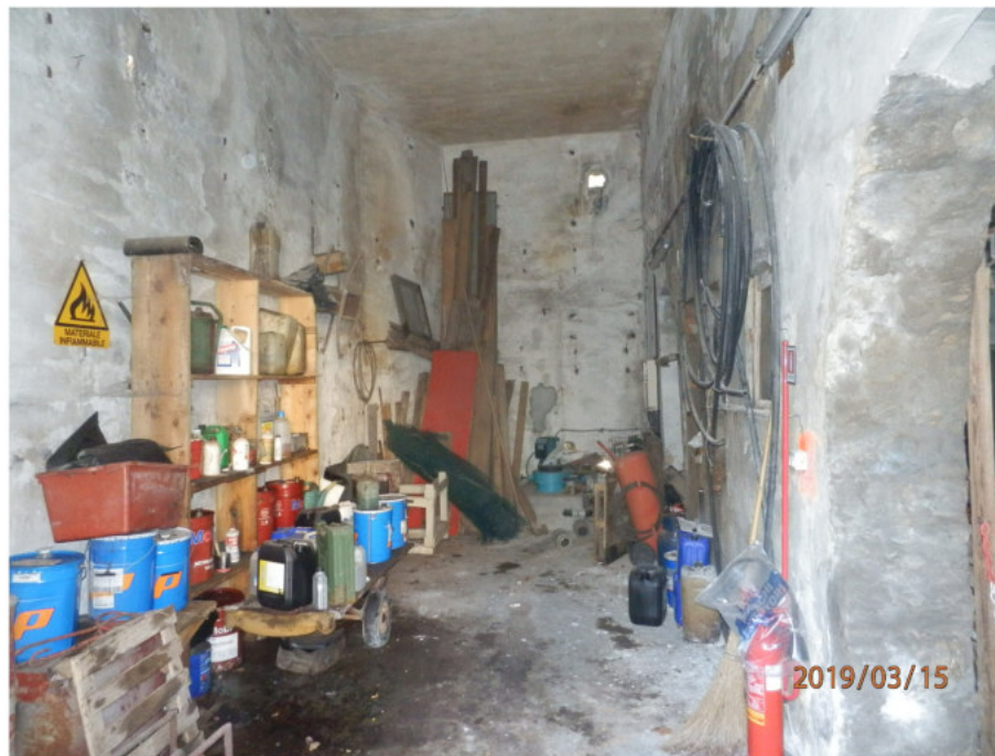
10 vista interna del magazzino I
