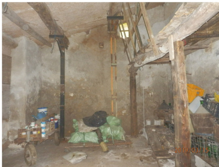
12 vista interna della cantina I
