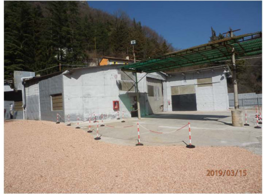
vista esterna del laboratorio artigianale
