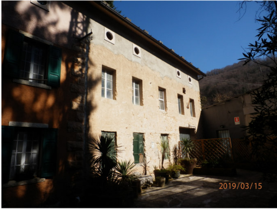
21 vista esterna del magazzino2
