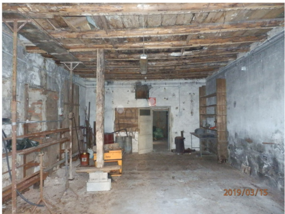
11 vista interna del magazzino I
