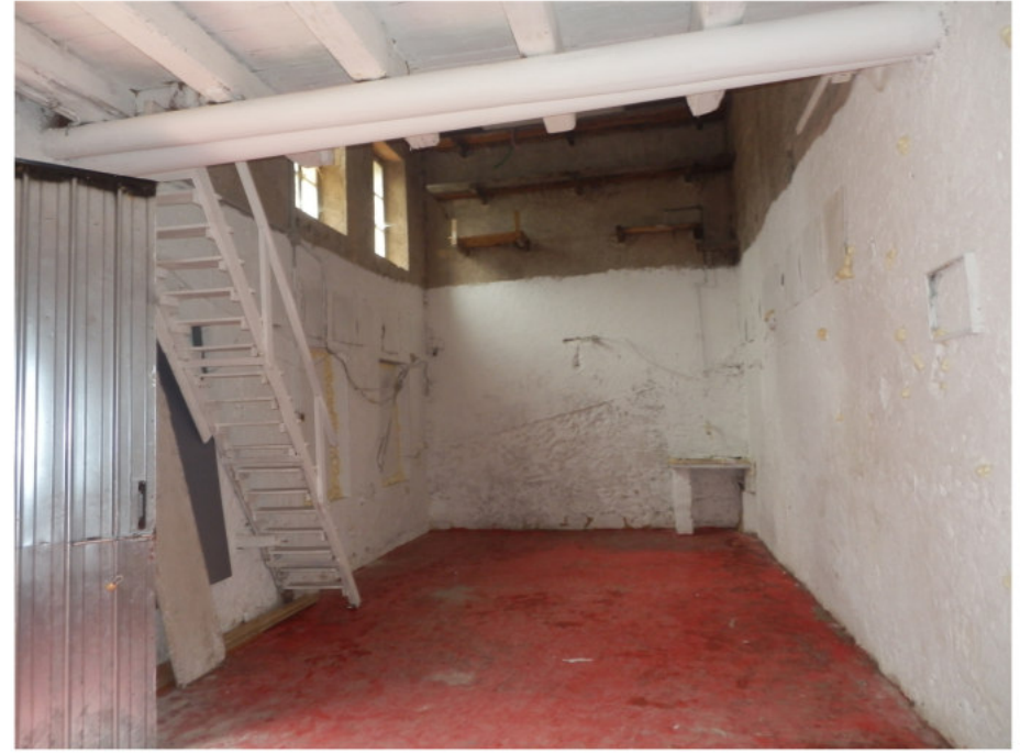
22 vista interna del magazzino2 PT
