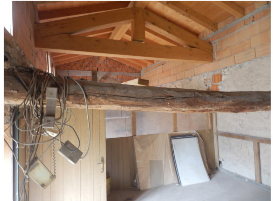
24 vista interna del magazzino2 P1
