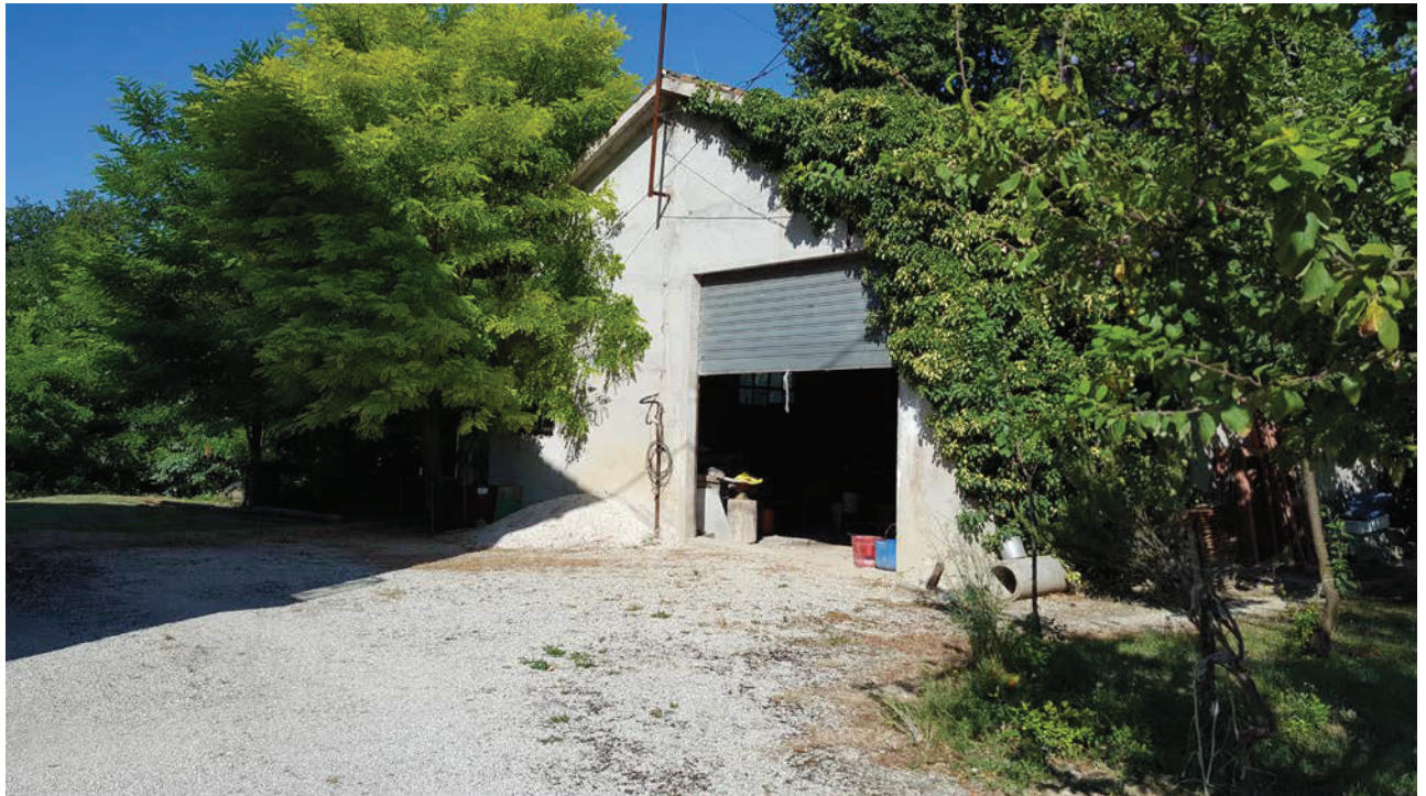
Foto 2 – scorcio dell'edificio corpo "B" lotto 1
