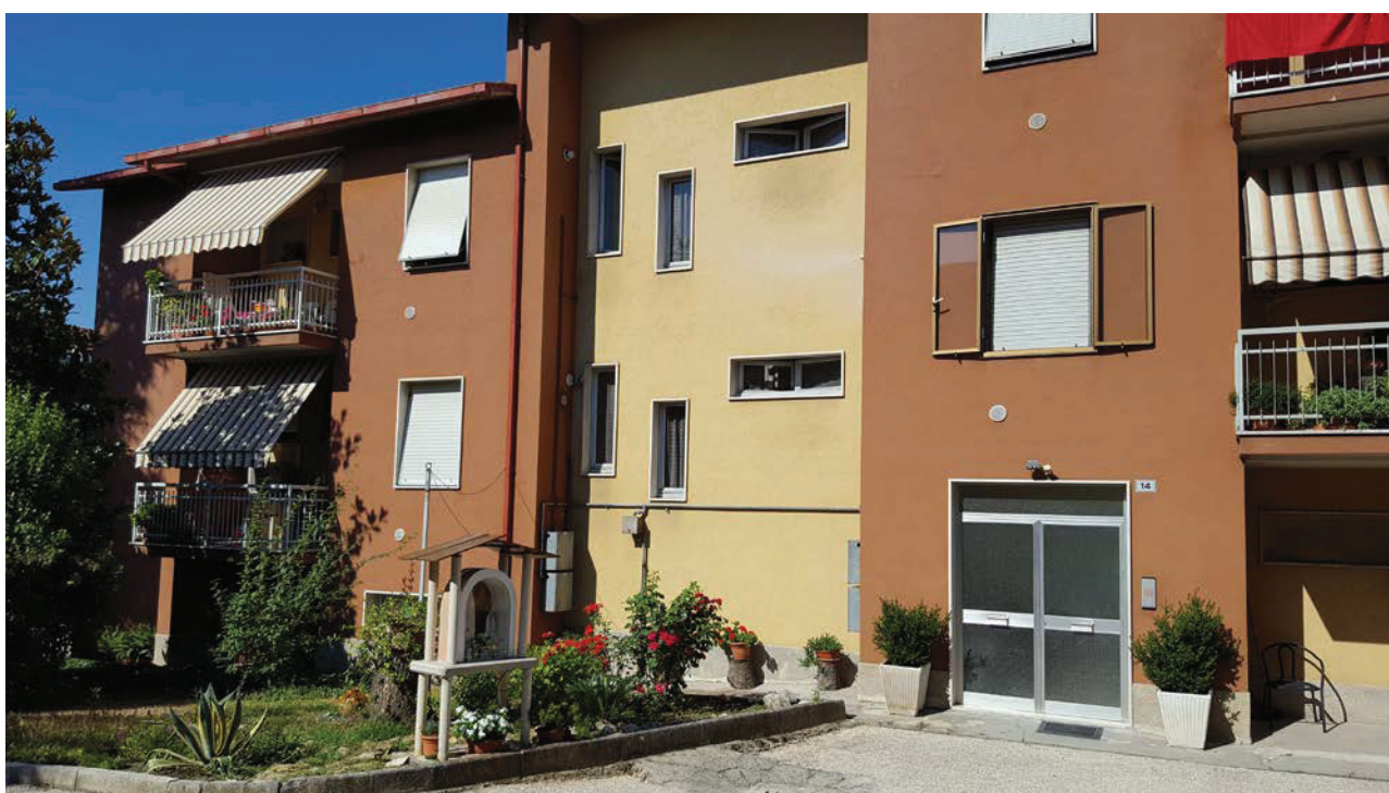
Foto 8 – Scorcio ingresso edificio ove è ubicato il lotto 3
