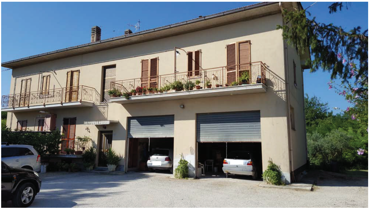
Foto 1 - vista del fronte principale dell'edificio principale del lotto 1 con ingresso dell'abitazione e i due accessi di parte del corpo B sempre del lotto1
