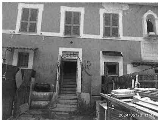
Scala di accesso al piano 1°
