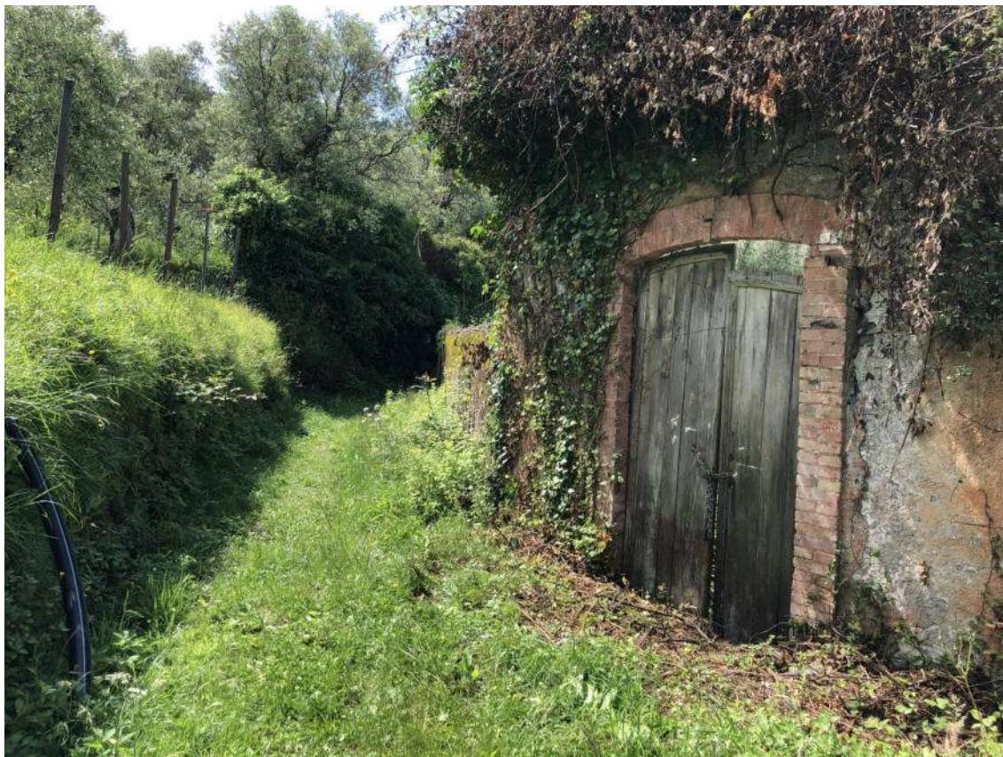
FOTO 11 ANTICO PORTALE DI INGRESSO
