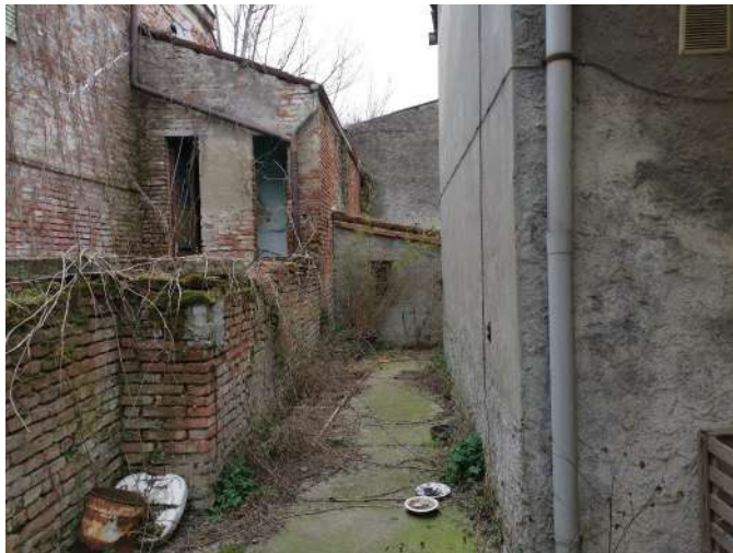
FOTO 33. rustici da cortile di proprietà -
