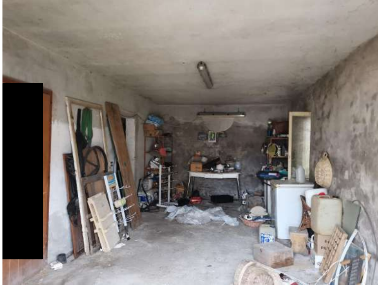
FOTO 37. vista cantina (sotto al fienile) -
