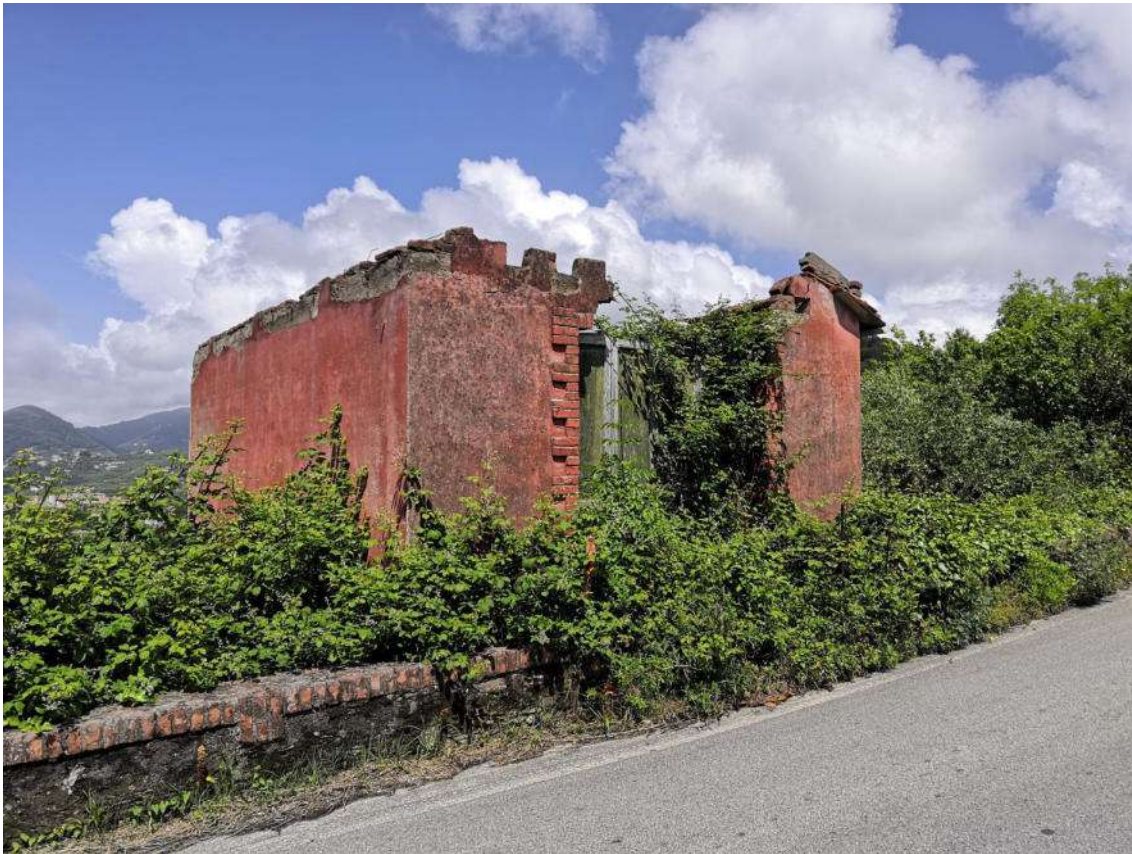
FOTO 3 FABBRICATO PART. 1647 – DIRUTO -
