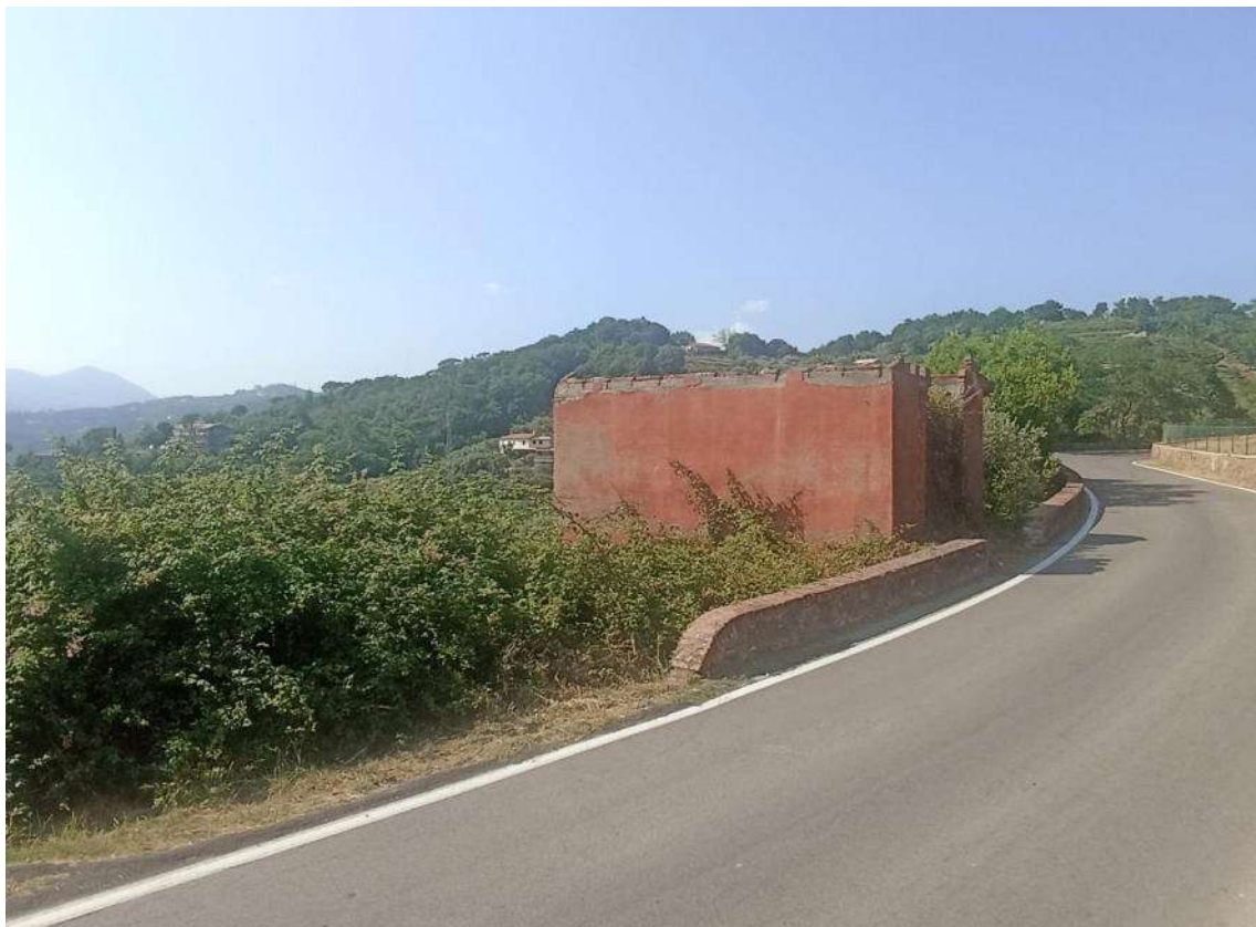
FOTO 4 FABBRICATO PART. 1647 – DIRUTO –
