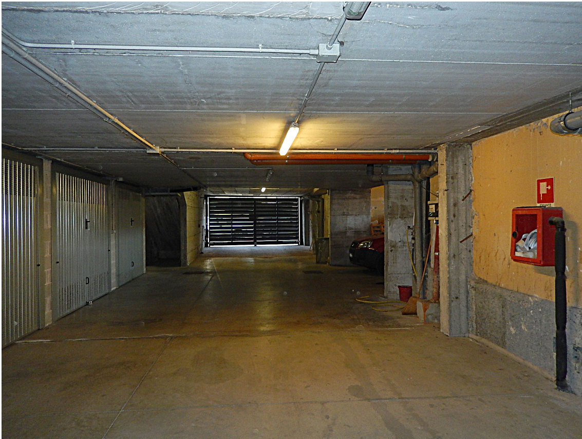
Foto 3 – Vista del corsello di manovra verso l'uscita.
