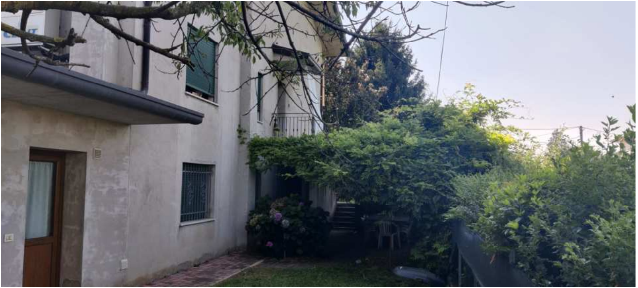
Foto n° 07 – Vista del lato Nord - Ovest
