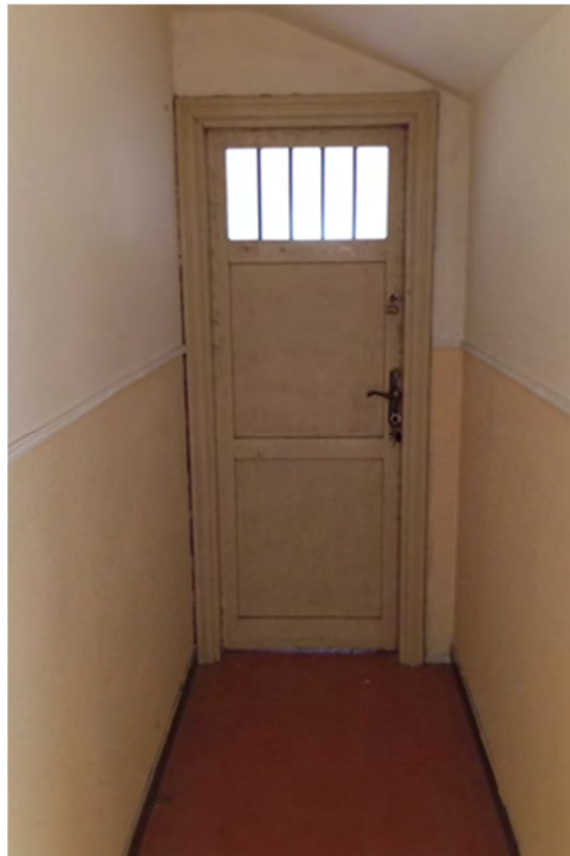
Foto 14_ Corridoio di distribuzione e porta di ingresso al locale deposito
