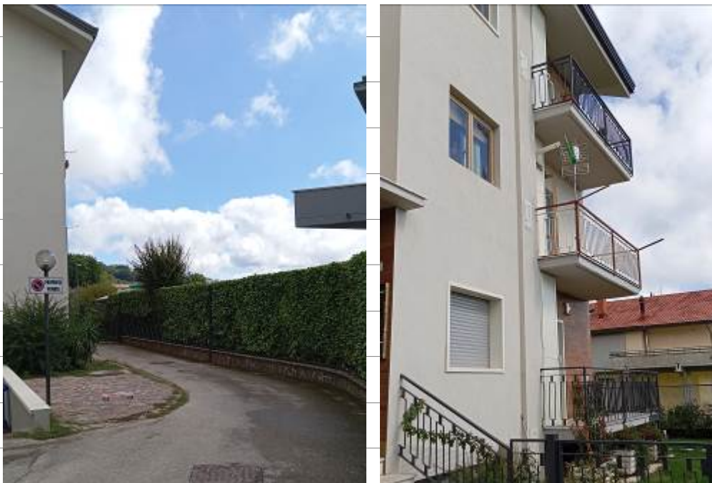
Foto 3 – 4_ Percorso di accesso e verticale del lato sud del fabbricato dove affaccia un balcone a piano primo dell'abitazione pignorata
