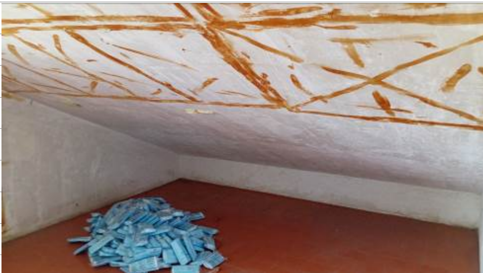
Foto 15 - 16 - 17_ Immagini del locale - deposito
