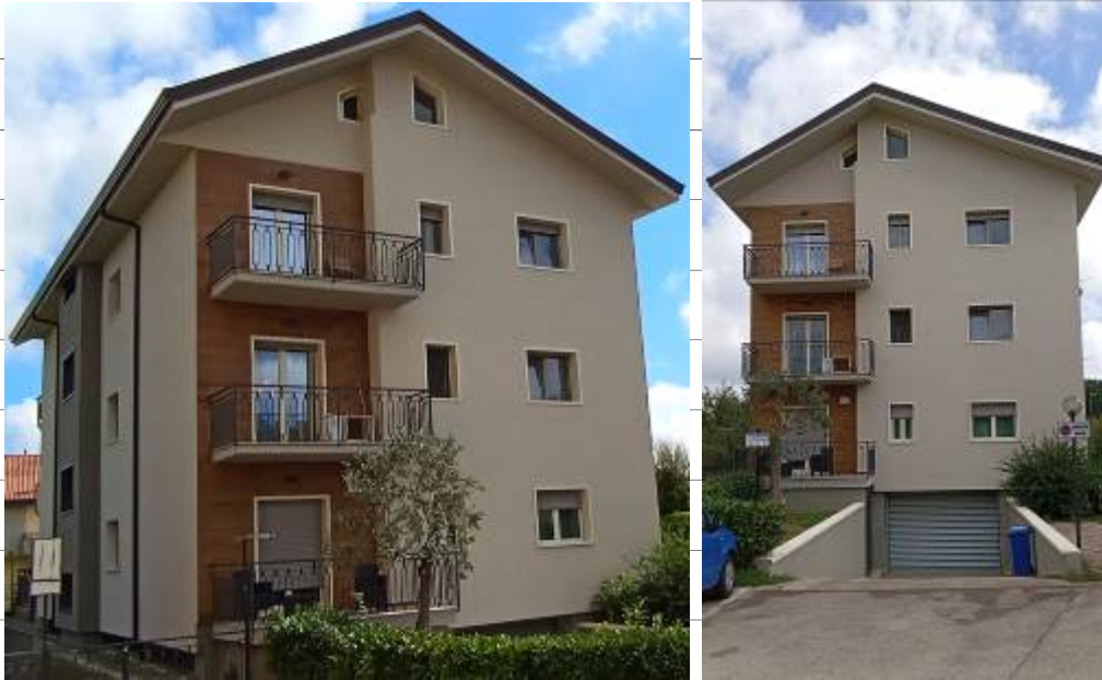
Foto 1 – 2_ Viste esterne dei lati nord e ovest del fabbricato
