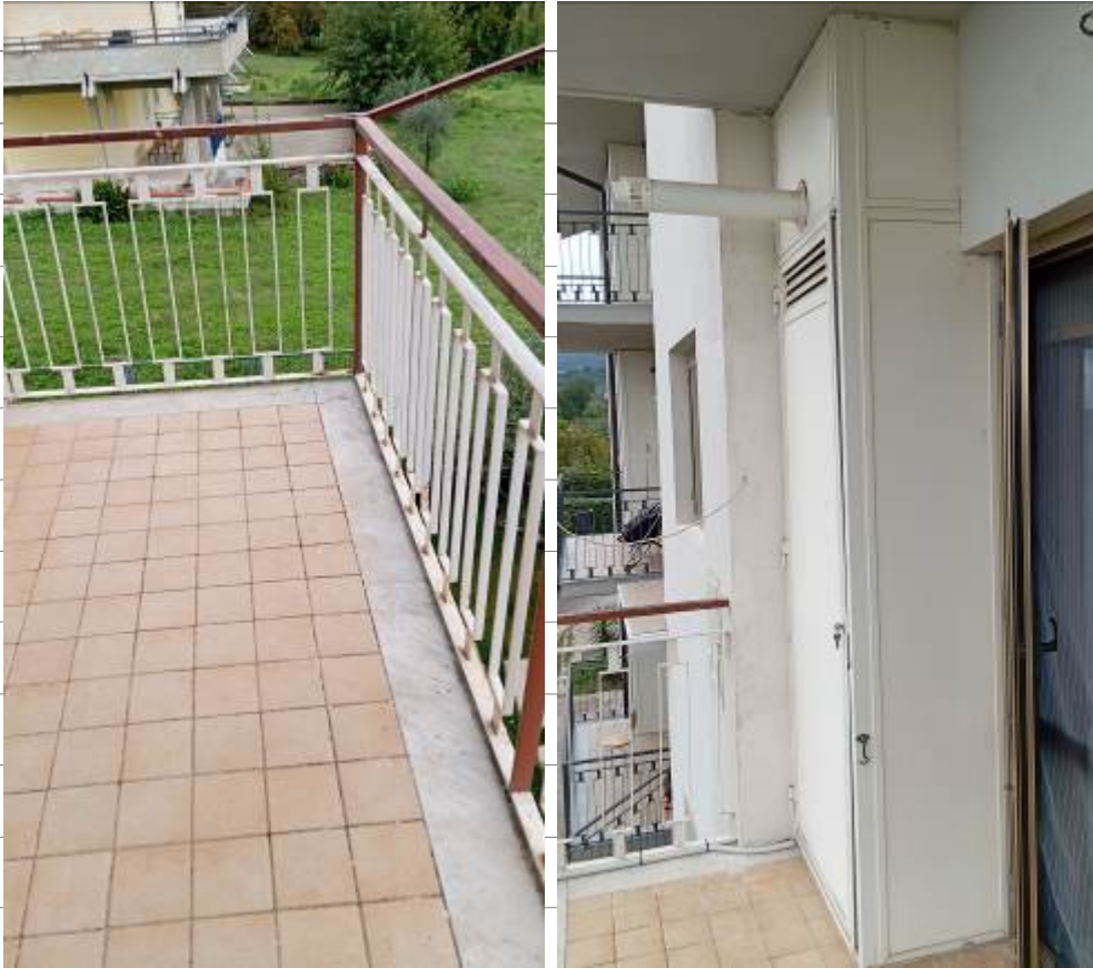
Foto 6 - 7 - 8_ Camera a destra entrando servita da balcone lato sud con caldaia
