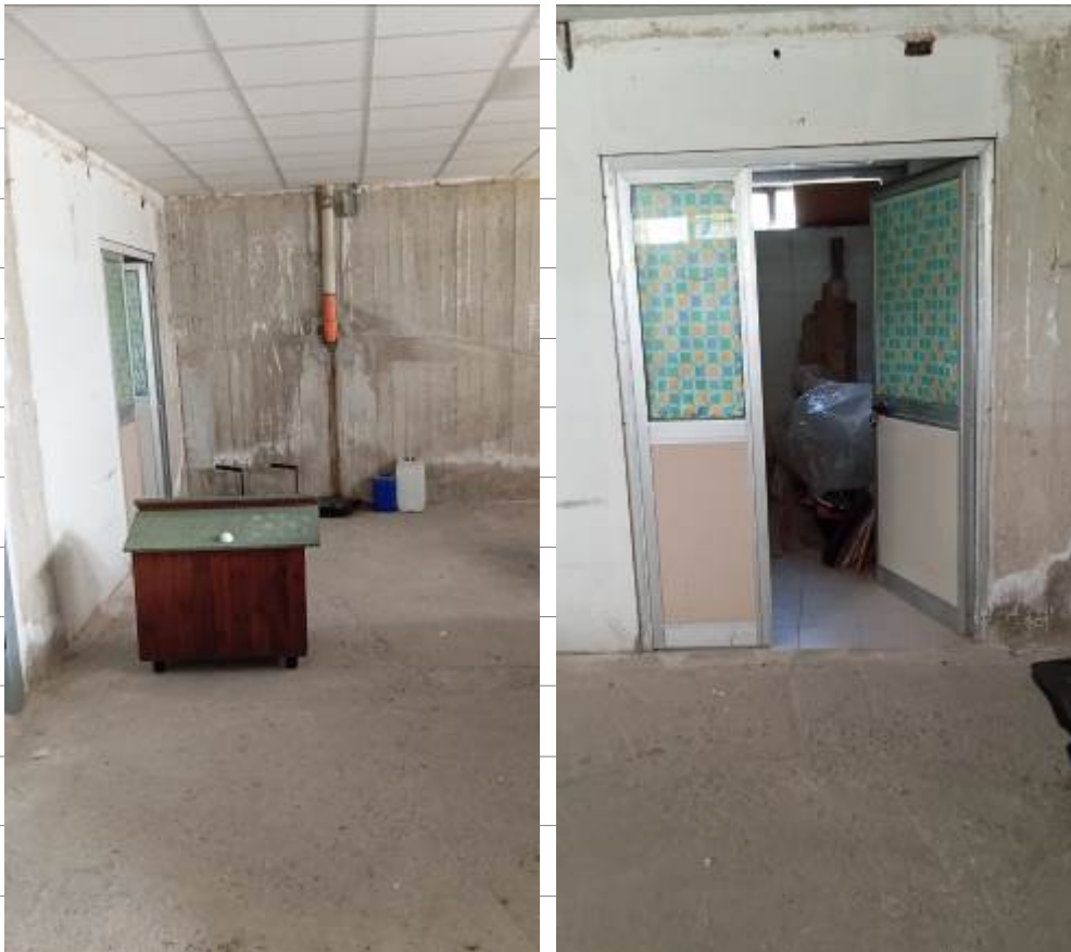
Foto 22 - 23_ Vista dello spazio di manovra esclusivo e dell'ingresso del locale – garage
