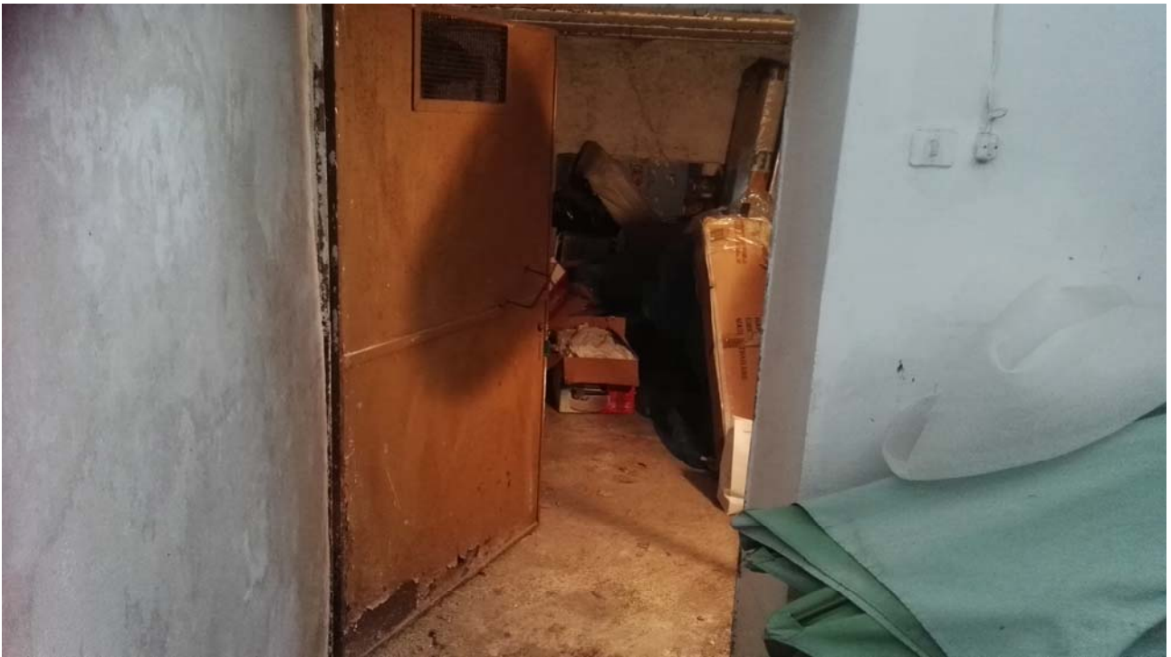
Foto 16 - vista ingresso cantinola
