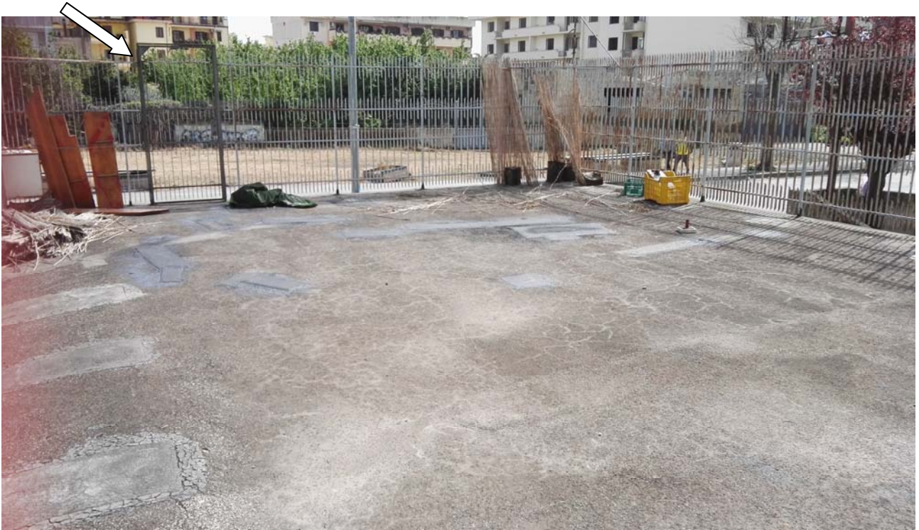
Foto 20 – vista del cancello su via Alcide de Gasperi
