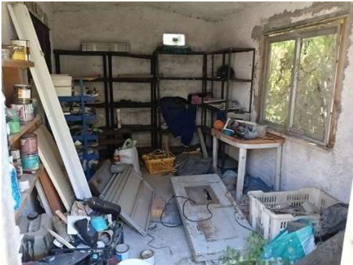
Struttura 3: locale deposito – Interno
