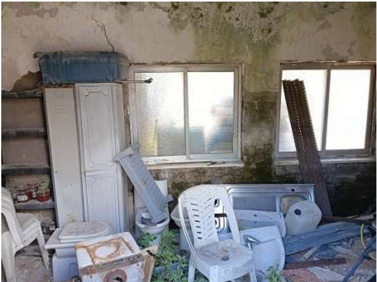
Struttura 2: cantina – Interno
