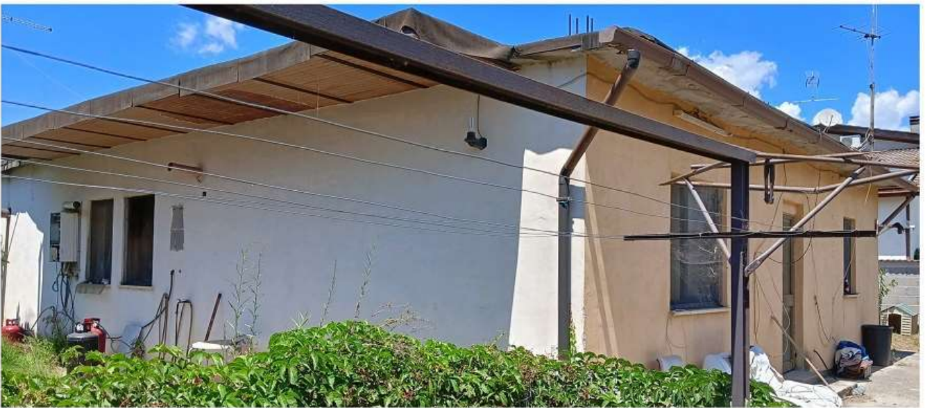
Struttura 4 (da demolire) – Viste esterne e adiacenza con struttura 1
