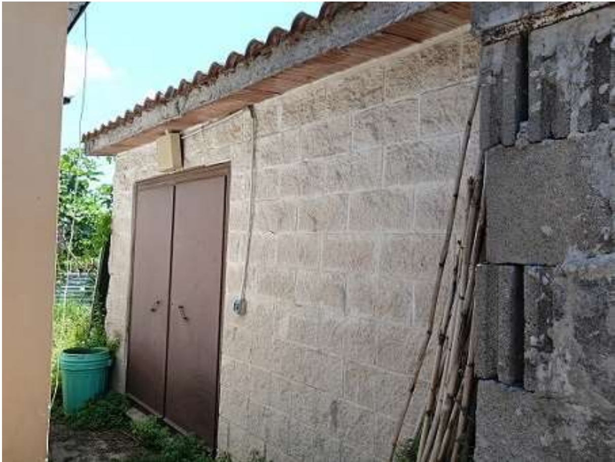
Struttura 3: locale deposito – Esterno
