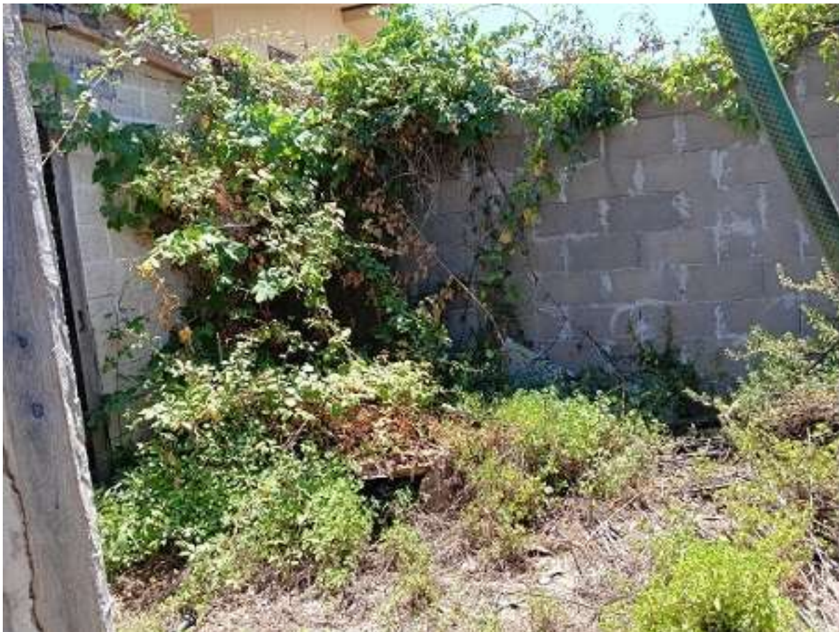
Struttura 5 – Pareti in blocchi di cemento (da demolire)
