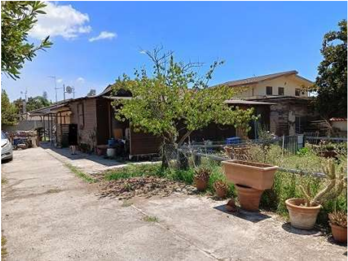
Struttura 1: Appartamento – Esterno (1)
