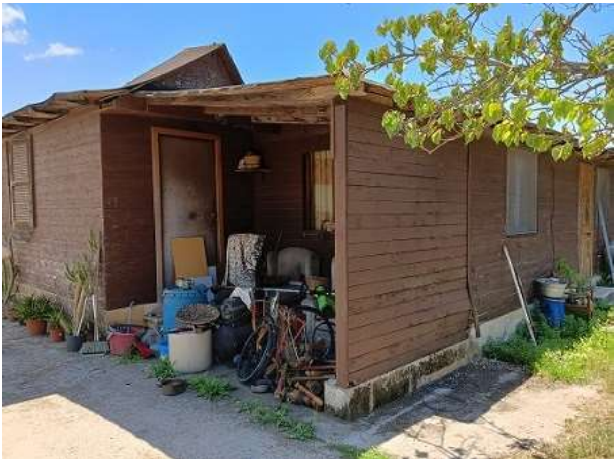
Struttura 1: Appartamento – Esterno (2)
