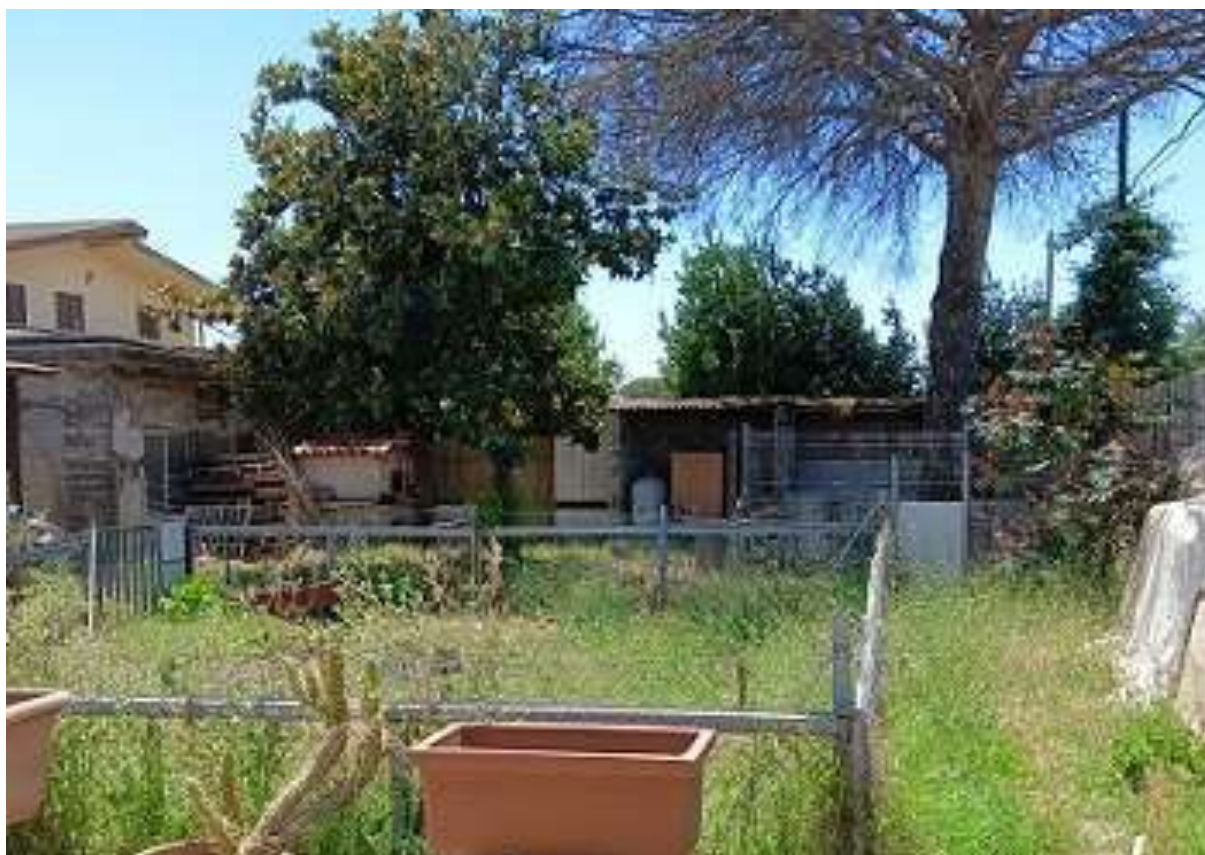
Blocco strutture 6 - tettoie (da demolire)
