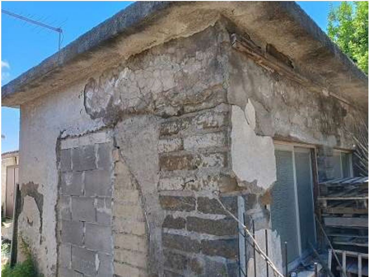
Struttura 2: cantina – Esterno
