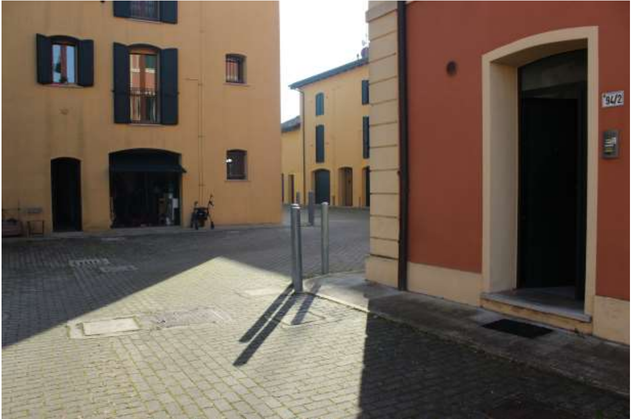
Edificio a nord con cantine (sub. 22)
