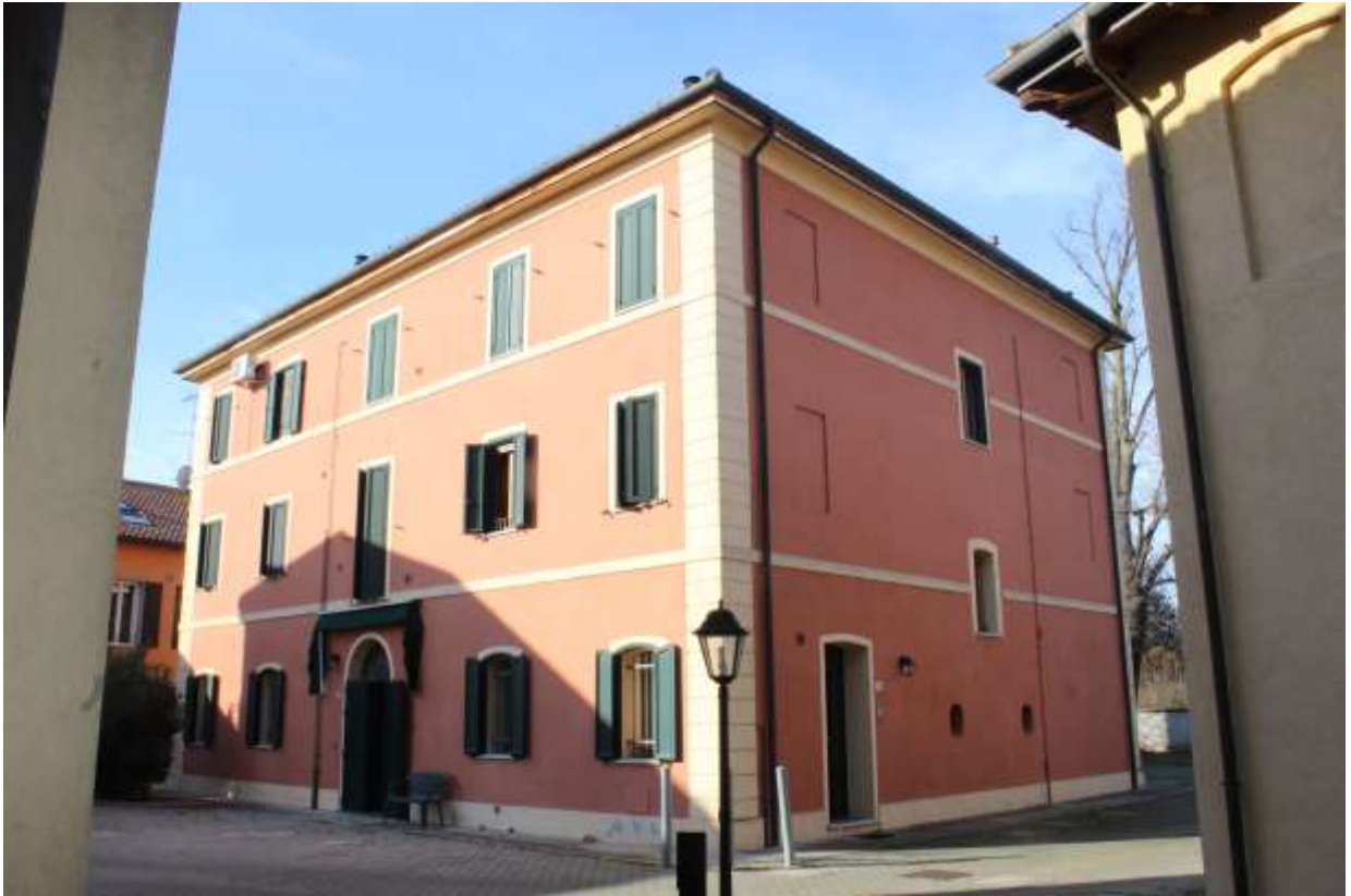
Edificio a nord-ovest della corte, ad uso abitativo (sub.15)
