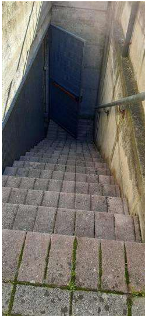
scala comune per accedere dal piano terra al piano seminterrato
