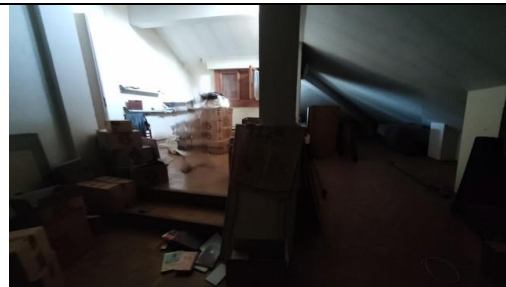
Locali abitativi piano sottotetto
