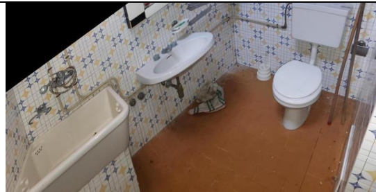
Bagno p. seminterrato
