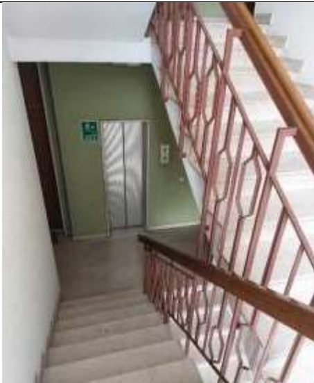
Foto 3: Vano scale e ascensore comuni
