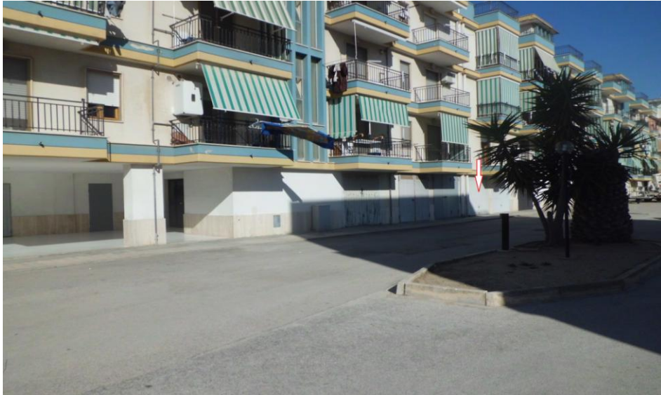
TIPOLOGIA PROSPETTICA DEL FABBRICATO ANTE BONUS 110% IN OPERA ALLA DATA DEL SOPRALLUOGO 10/02/2023
