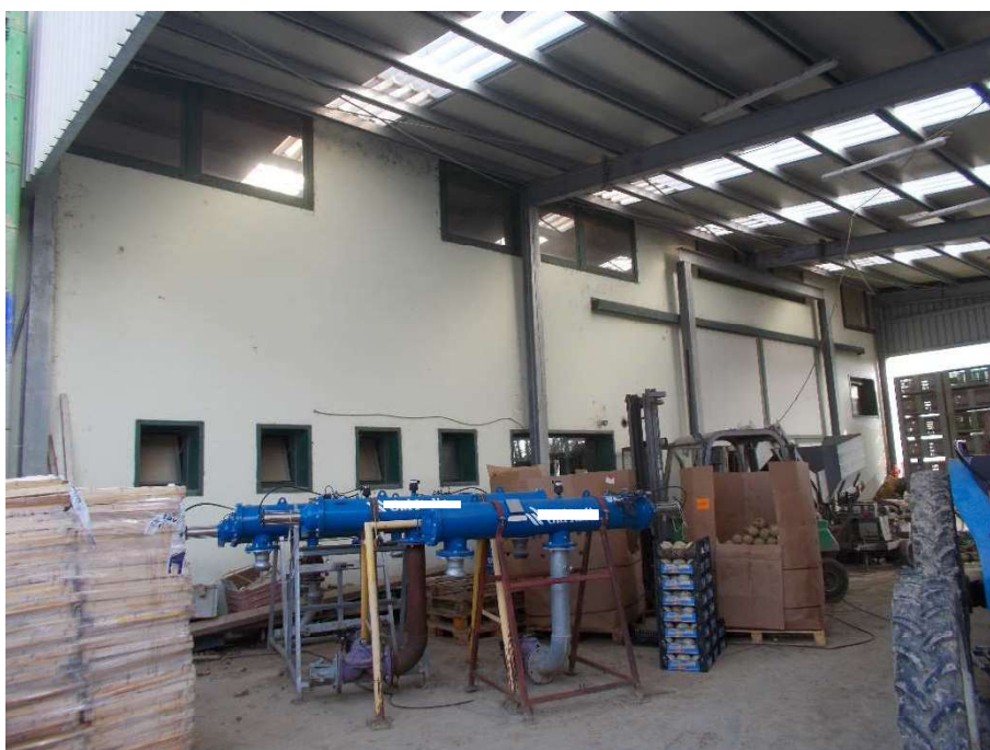
Lotto 2-Tettoia di collegamento
