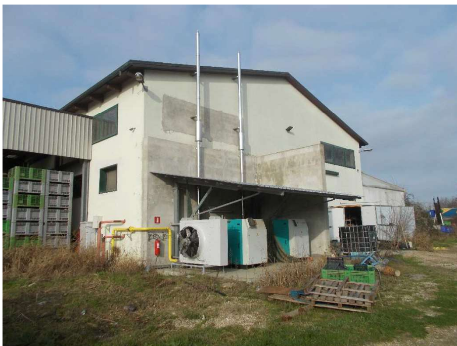
Lotto 2-Vista esterna corpo magazzino
