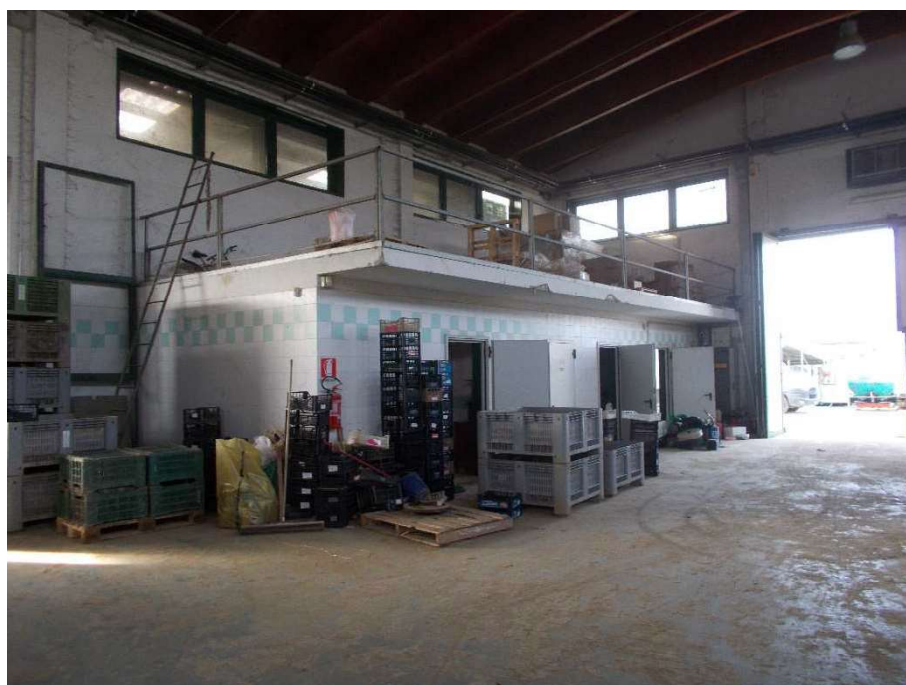
Lotto 2-Vista interna magazzino
