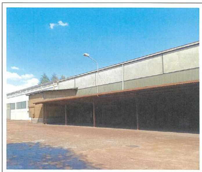
14 – tettoia esterna, in corpo staccato, con struttura metallica e copertura in lamiera grecata
