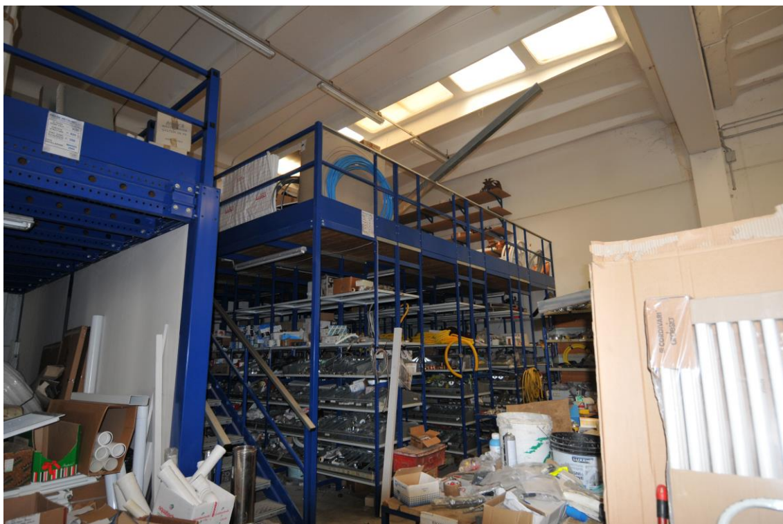
Foto 5 – LOTTO 1 – Interno e sopalchi in acciaio.
