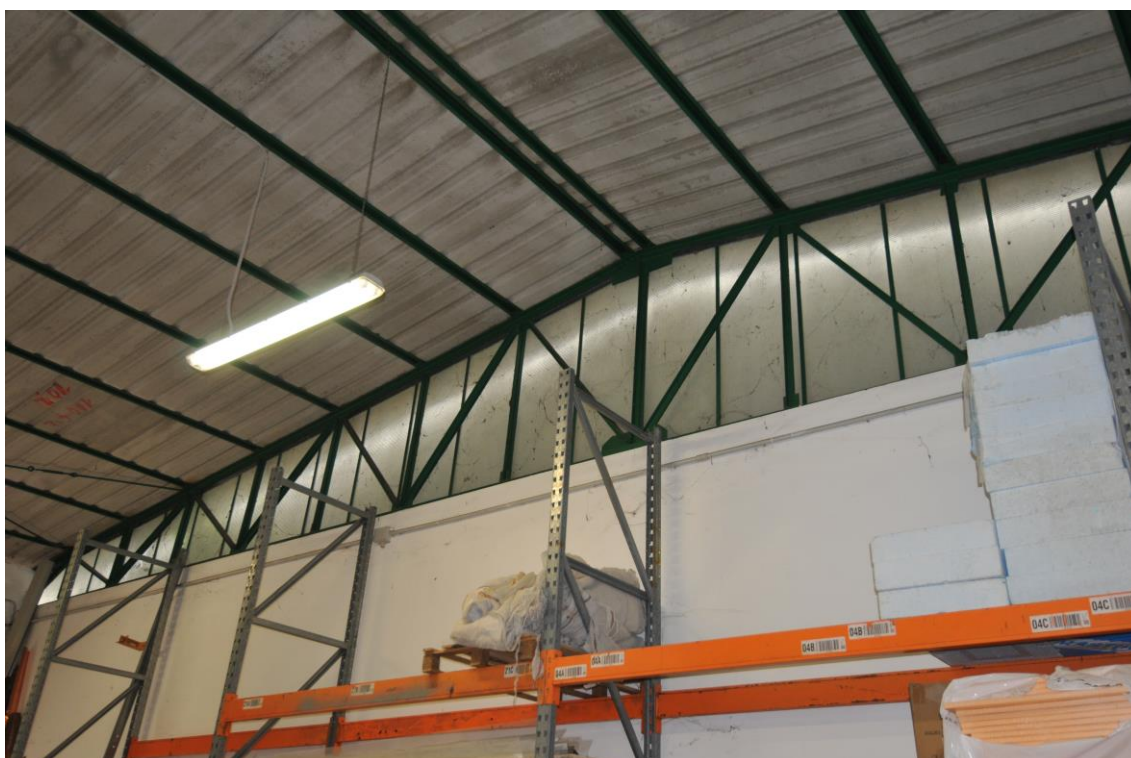
Foto 9 – LOTTO 2 – Particolare della copertura.
