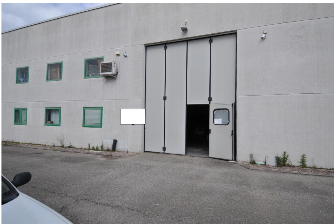
Foto 3 – LOTTO 1 – Prospetto Sud-Est e porta di accesso.
