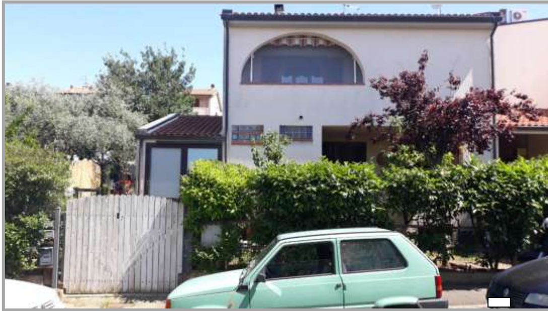
Foto " 1 " – Vista dell'appartamento e dell'accesso dotato di scivolo carrabile
