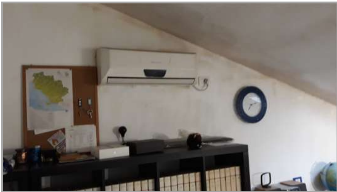
Foto " 22 " – Vista del vano sottotetto ove è presente un locale deposito
