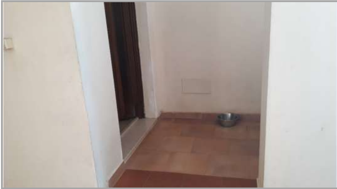
Foto " 7 " – Vista del disimpegno al piano terreno che permette l'accesso alle scale a servizio esclusivo dell'appartamento
