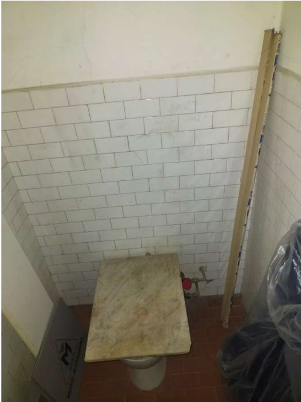
Bagno di servizio su vano scala
