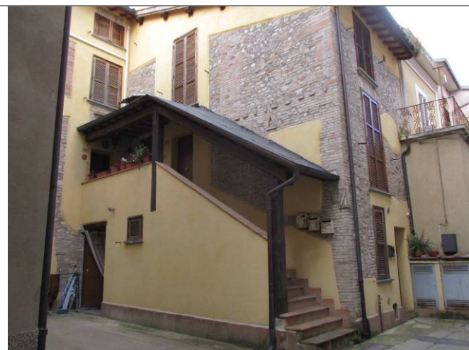
Foto n. 1 - Vista edificio - Via Clitunno
