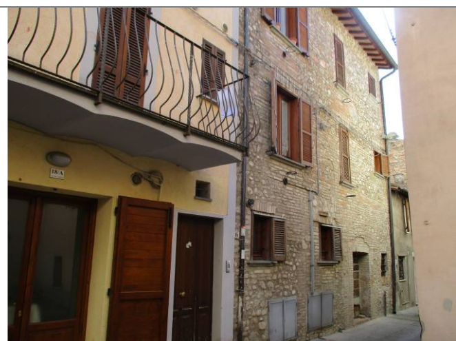
Foto n. 3 - Vista edificio - Via Lago Persio
