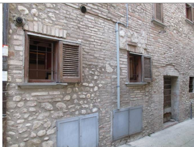
Foto n. 4 - Vista edificio - Via Lago Persio
