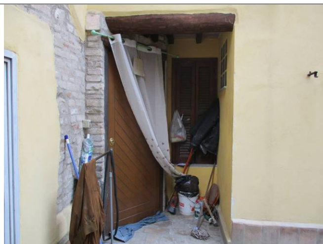
Foto n. 2 - Ingresso monolocale - civico 7/B
