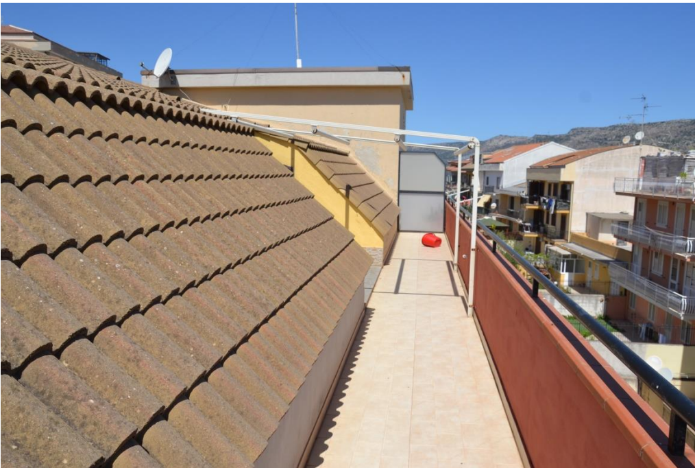
Fot.n°14: balcone perimetrale, lato nord-est
