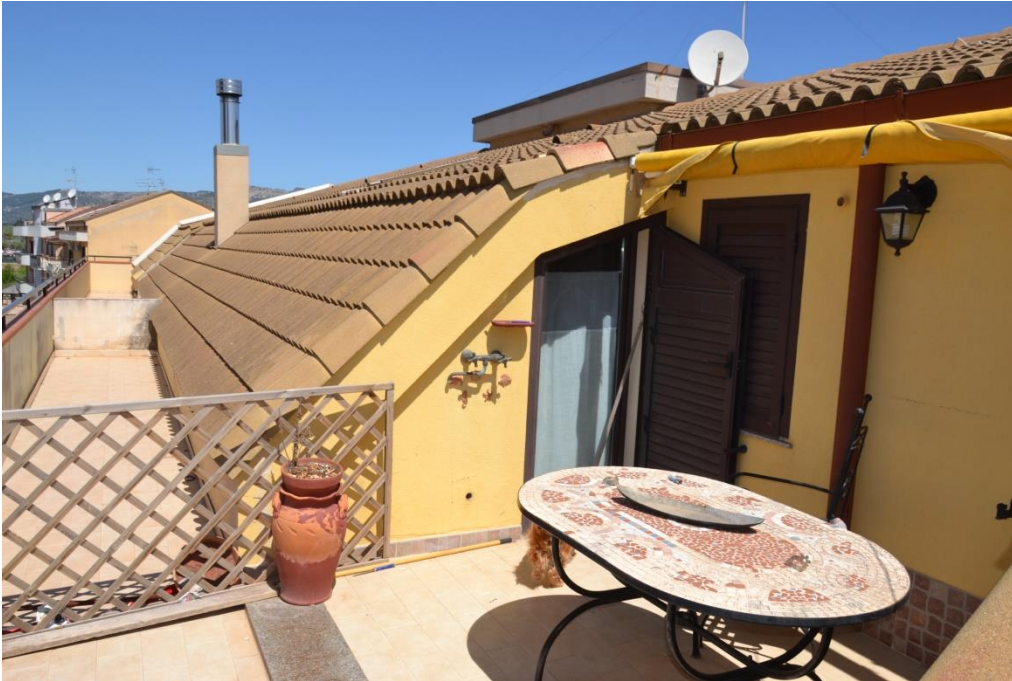
Fot.n°11: terrazzino lato nord-ovest
