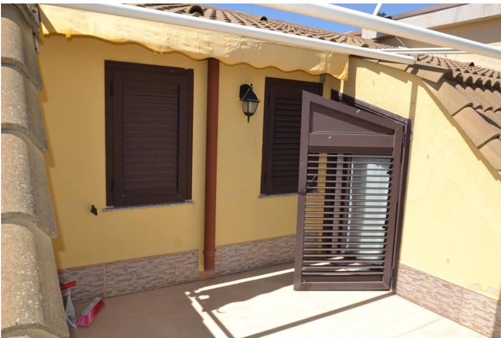
Fot.n°12: terrazzino lato nord-est
