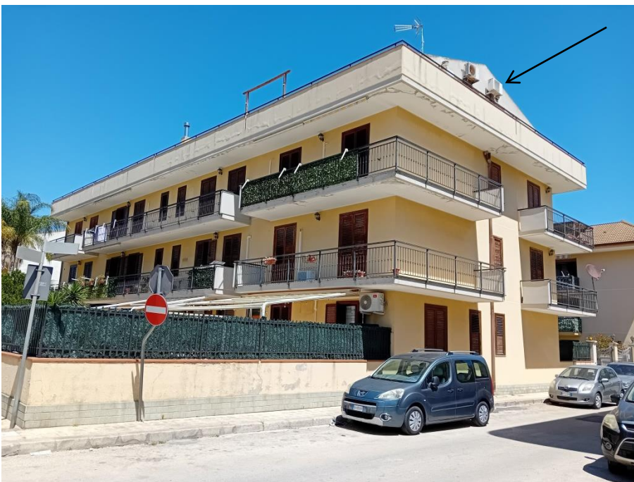
Fot.n°16: vista angolo via Fagone e via dei Platani.
