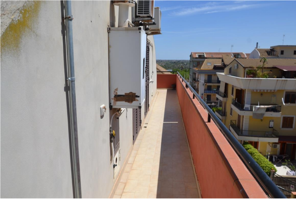
Fot.n°13: balcone perimetrale, lato sud-est
