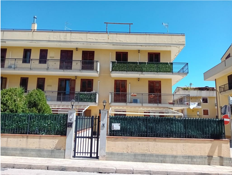
Fot.n°15: prospetto sud-ovest
