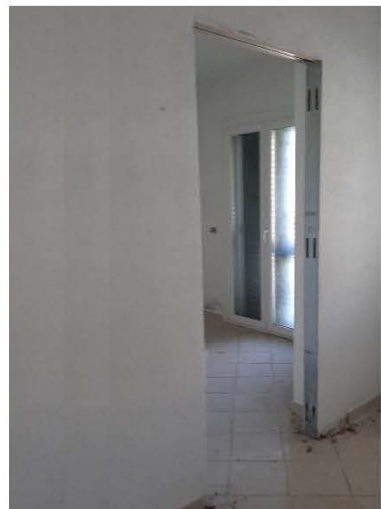
Foto 15 Vista Locale cucina
