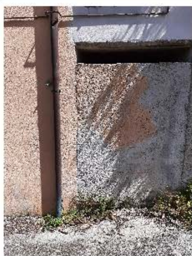
Foto 5 Particolare intercapedine Vista dalla rampa d'accesso
