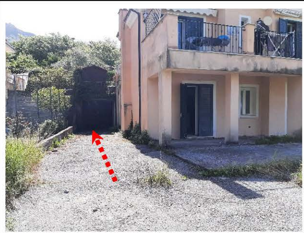
Foto 33 Vista esterna garage da corte esclusiva (sub1)
