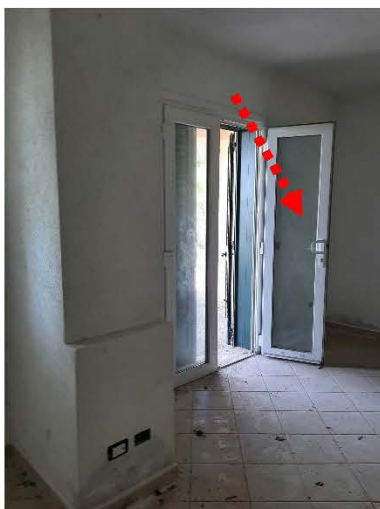
Foto 11 Locale I-S-P – Particolare porta-finestra con serratura
