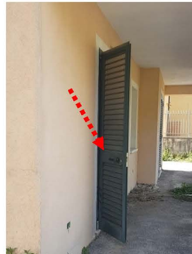
Foto 10 Particolare porta-finestra con serratura - accesso I-S-P
