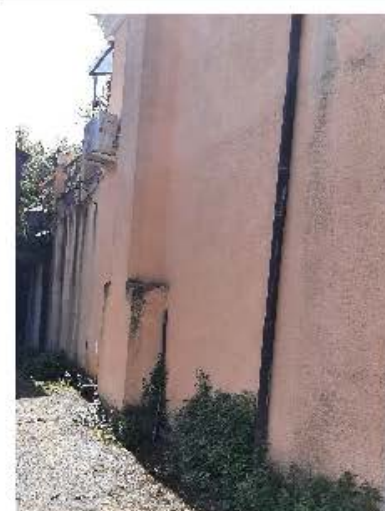
Foto 7 Vista esterna lato nord-est
