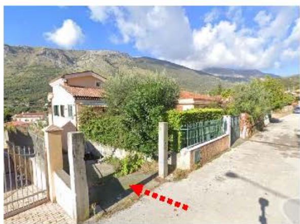
Foto 1 Vista ingresso principale – lato sud-est da Strada privata
