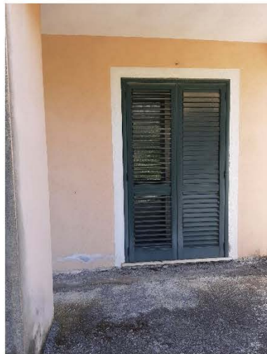
Foto 9 Particolare porta-finestra Locale cucina
