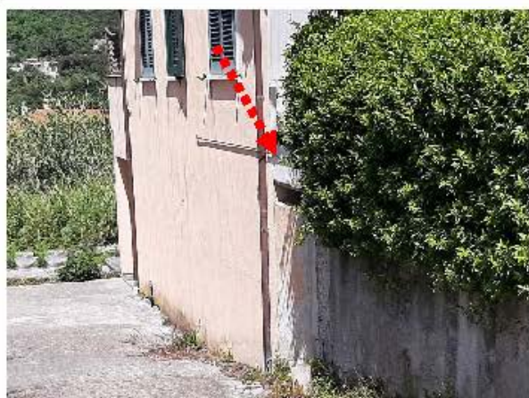
Foto 3 Vista esterna appartamento piano S1 - Particolare intercapedine
