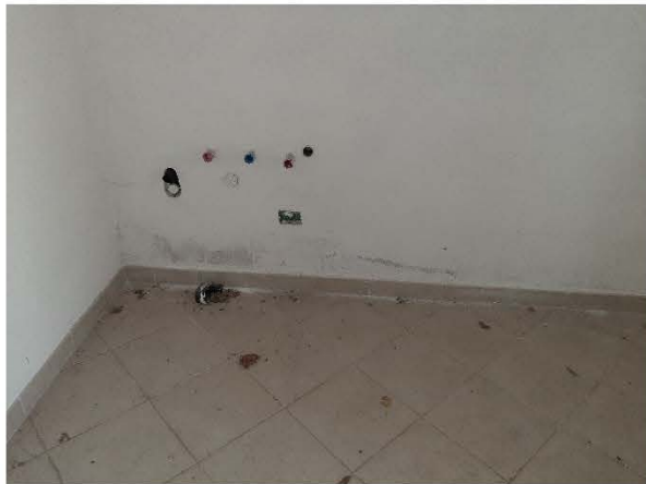
Foto 17 Locale cucina- Particolare attacco servizi
