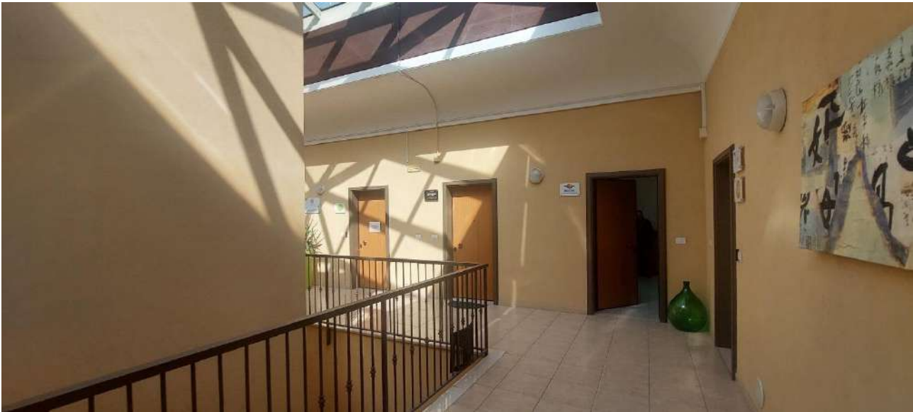
Ballatoio condominiale da cui si accede all'ufficio
