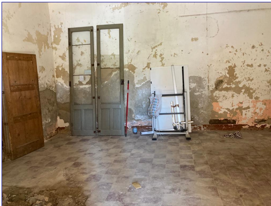
Foto 18 – Imm. 3 – Interno del locale destinato a negozio/botteghe.
