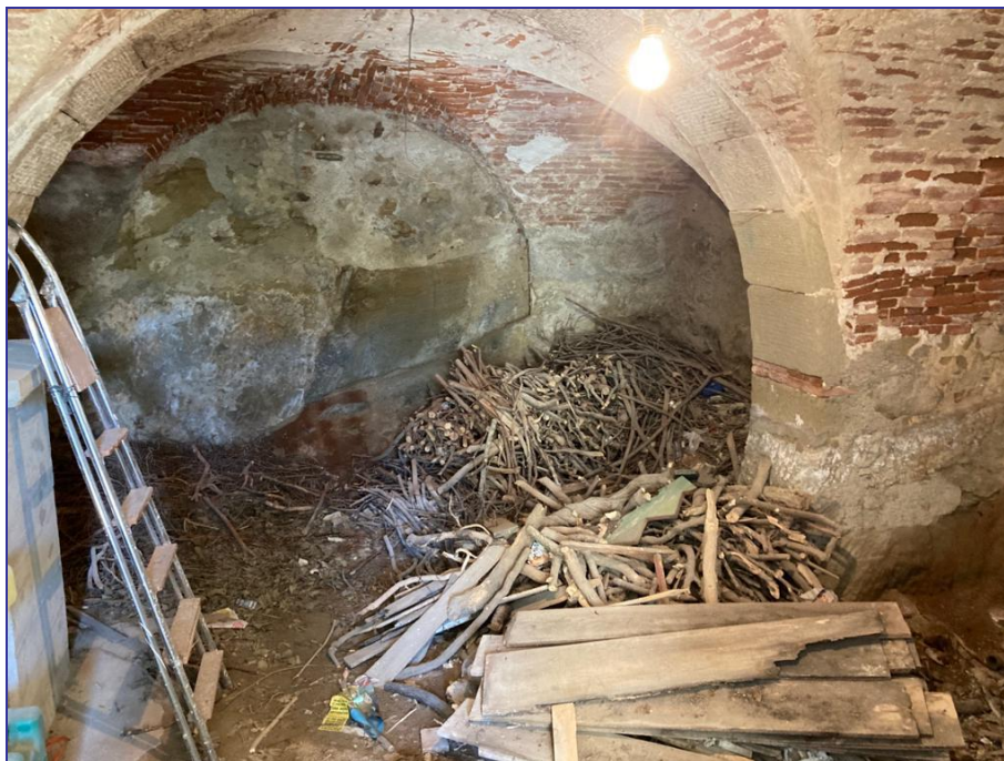
Foto 7 – Imm. 1 – Altra vista interna del deposito.
