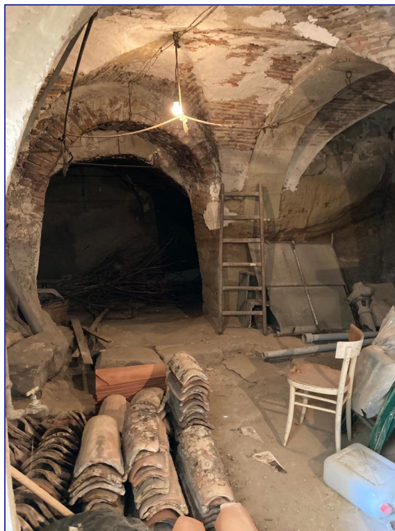
Foto 5 – Imm. 1 – Altra vista interna.
