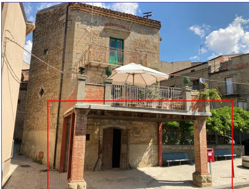
Foto 16 – Imm. 3 – Ingresso del locale commerciale, posto al piano terra della via Acquanova.
