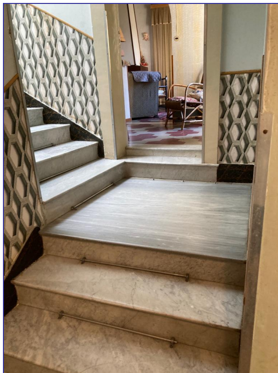
Foto 47 – Imm. 4 - Scala interna di collegamento piano primo e secondo.
