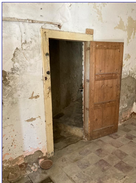
Foto 19 – Imm. 3 – Porta interna per accesso al servizio esistente interno al locale commerciale.
