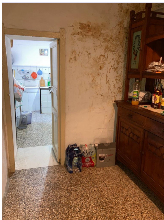
Foto 36 – Imm. 4 – Piano primo - Vano collegamento con cucina.
