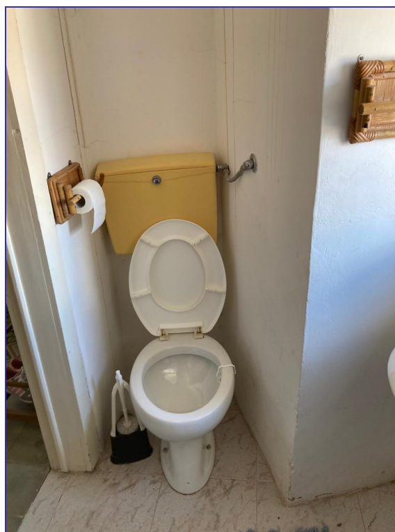
Foto 54 – Imm. 4 – Piano secondo - Bagno in camera.
