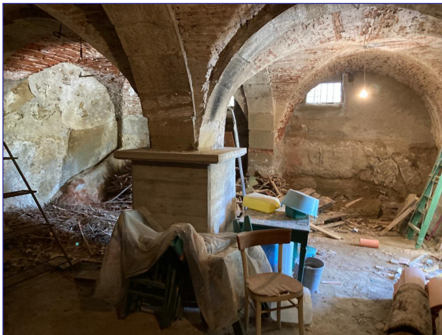
Foto 9 – Imm. 1 - Vista di tutto il magazzino con accesso sulla destra.
