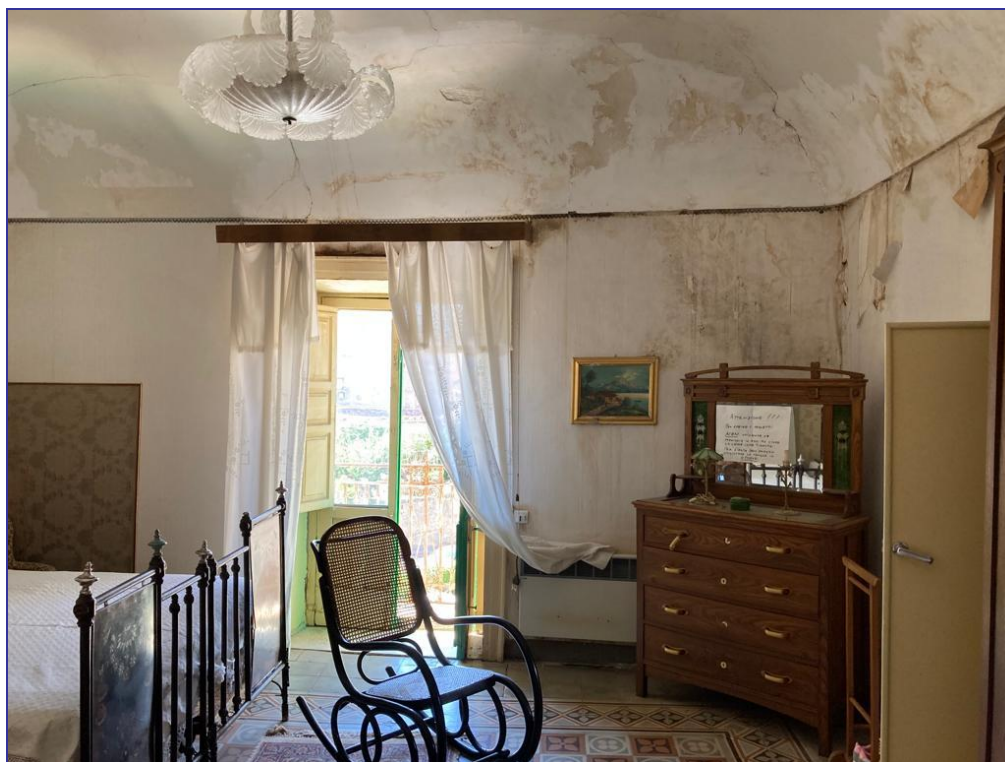
Foto 53 – Imm. 4 – Piano secondo – Vista camera con ingresso al bagno dedicato.
