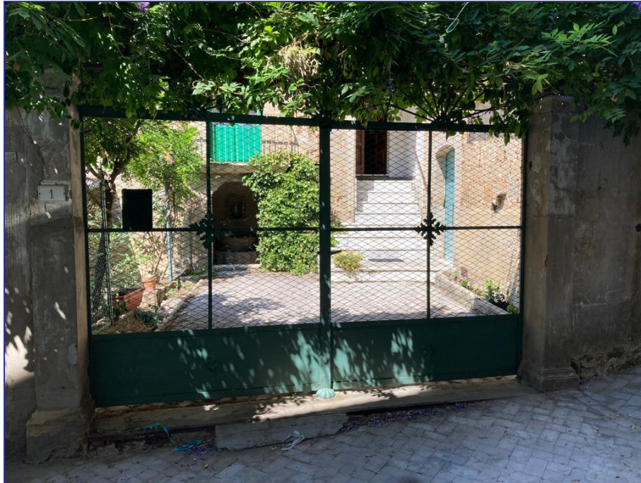
Foto 27 – Imm. 4 - Accesso alla corte, parte abitativa posta al piano primo e secondo ed ai magazzini/locale deposito posti al piano terra.
