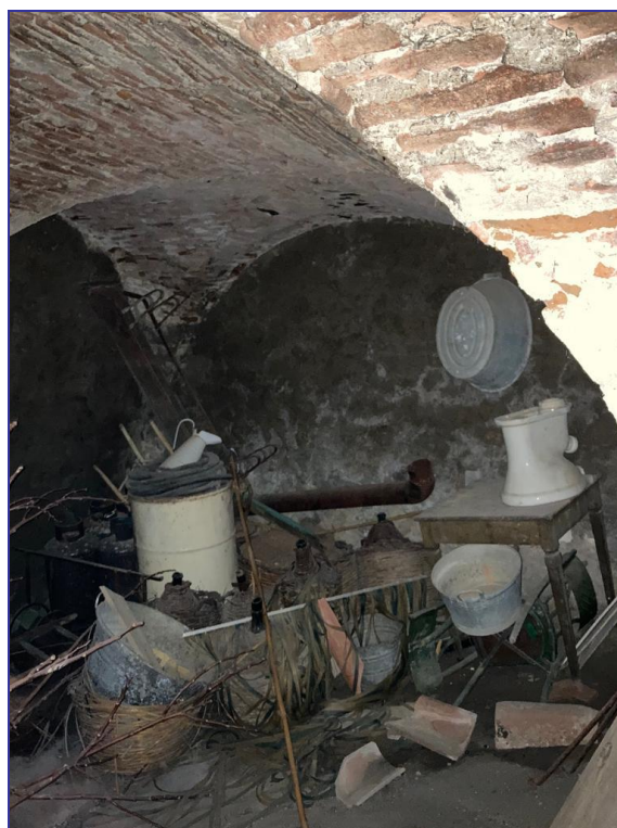
Foto 15 – Imm. 2 – Altra vista interna dell'immobile.
