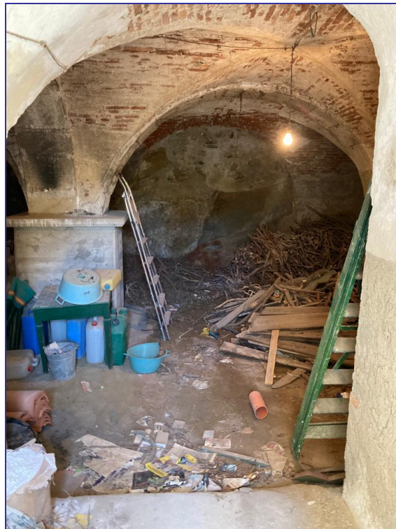
Foto 4 – Imm. 1 - Vista dell’interno del deposito con copertura ad arco e pilastro al centro.
