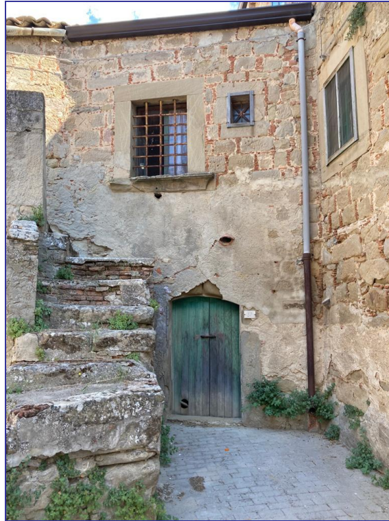
Foto 10 – Imm. 2 - Ingresso dell'immobile con accesso dal vicolo chiuso raggiungibile dalla via Acquanova, adiacente al corpo di fabbrica.
