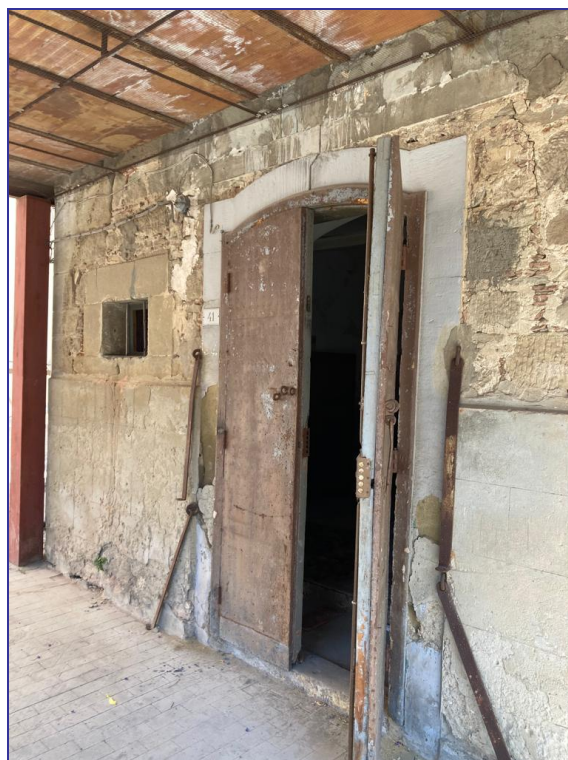
Foto 17 – Imm. 3 – Unico accesso al locale commerciale (negozio/botteghe).
