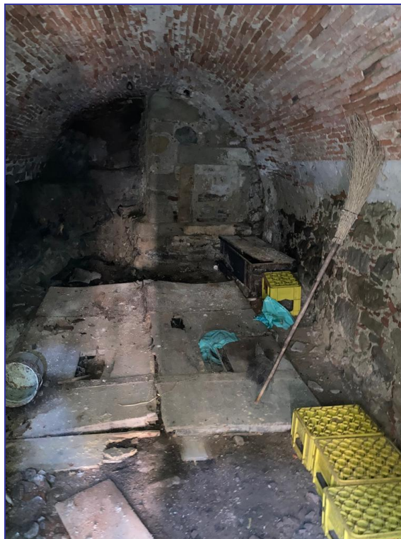
Foto 11 – Imm. 2 – Interno dell'immobile destinato a magazzino/locale di deposito.
