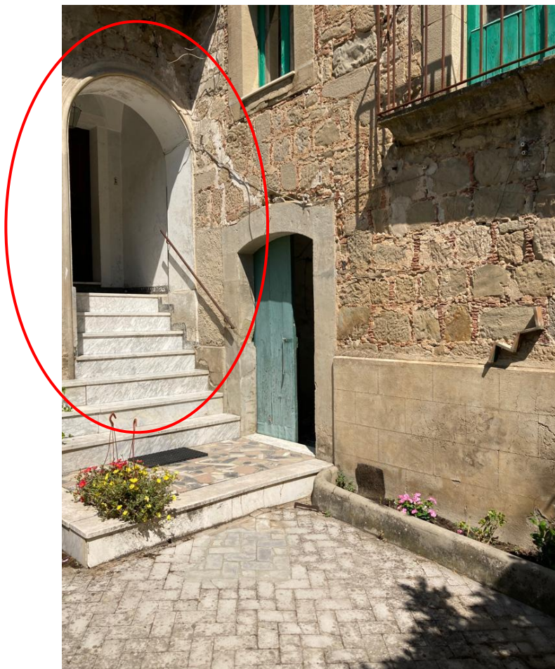
Foto 28 – Imm. 4 - Ingresso alla parte abitativa del piano primo e secondo.
