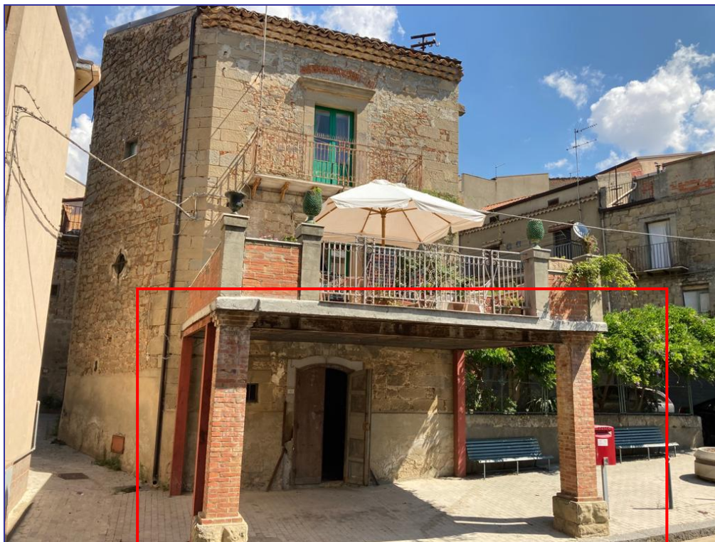
Foto 16 – Imm. 3 – Ingresso del locale commerciale, posto al piano terra della via Acquanova.
