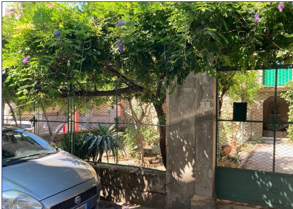
Foto 26 – Imm. 4 – Corte facente parte dell'abitazione alla parte abitativa posta al piano primo e secondo, ma che permette l'accesso ai locali magazzini/deposito del piano terra.
