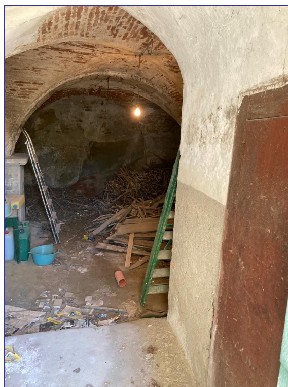
Foto 8 – Imm. 1 – Ingresso al piccolo ripostiglio in adiacenza al magazzino.
