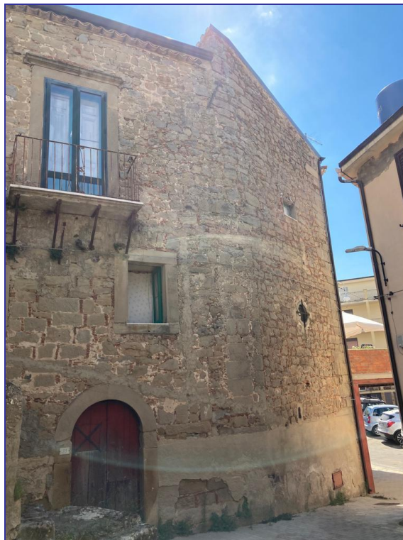
Foto 24 – Imm. 4- Prospetto lungo il vicolo cieco raggiungibile dalla via Acquanova.
