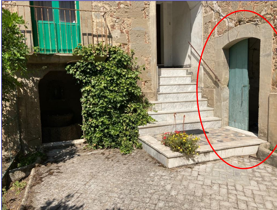
Foto 3 – Imm. 1 – Ingresso dalla corte facente parte dell’abitazione ad uno dei depositi posti al piano terra.
