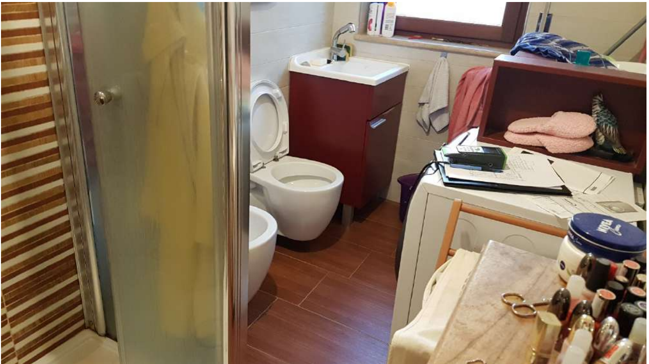
Foto n. 33 - Part. 1177 sub 1 – P. Primo – Lavanderia / w.c.
