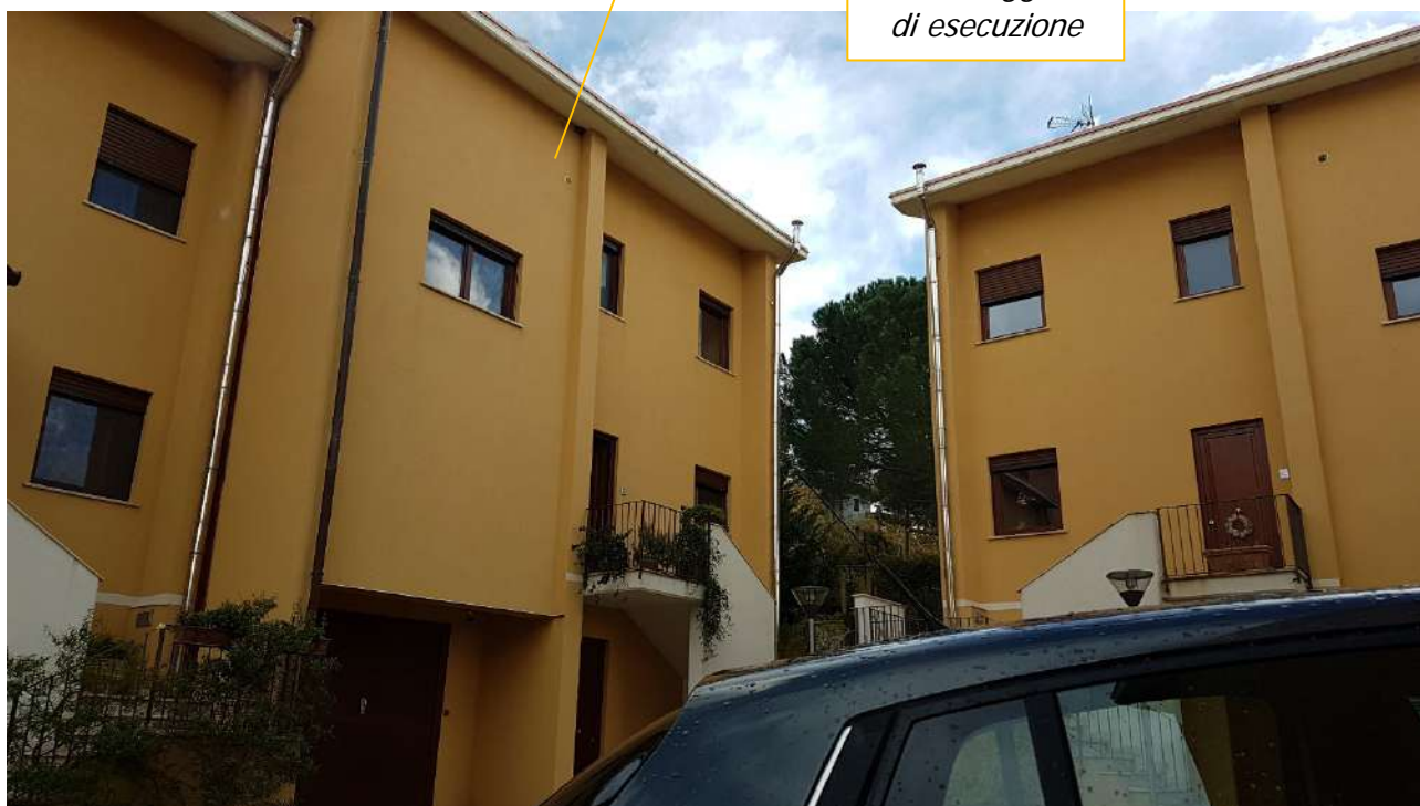
Foto n. 2 – Corte comune (Lato valle)
