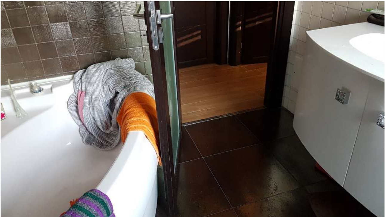
Foto n. 43 - Part. 1177 sub 1 – P. Secondo – Bagno
