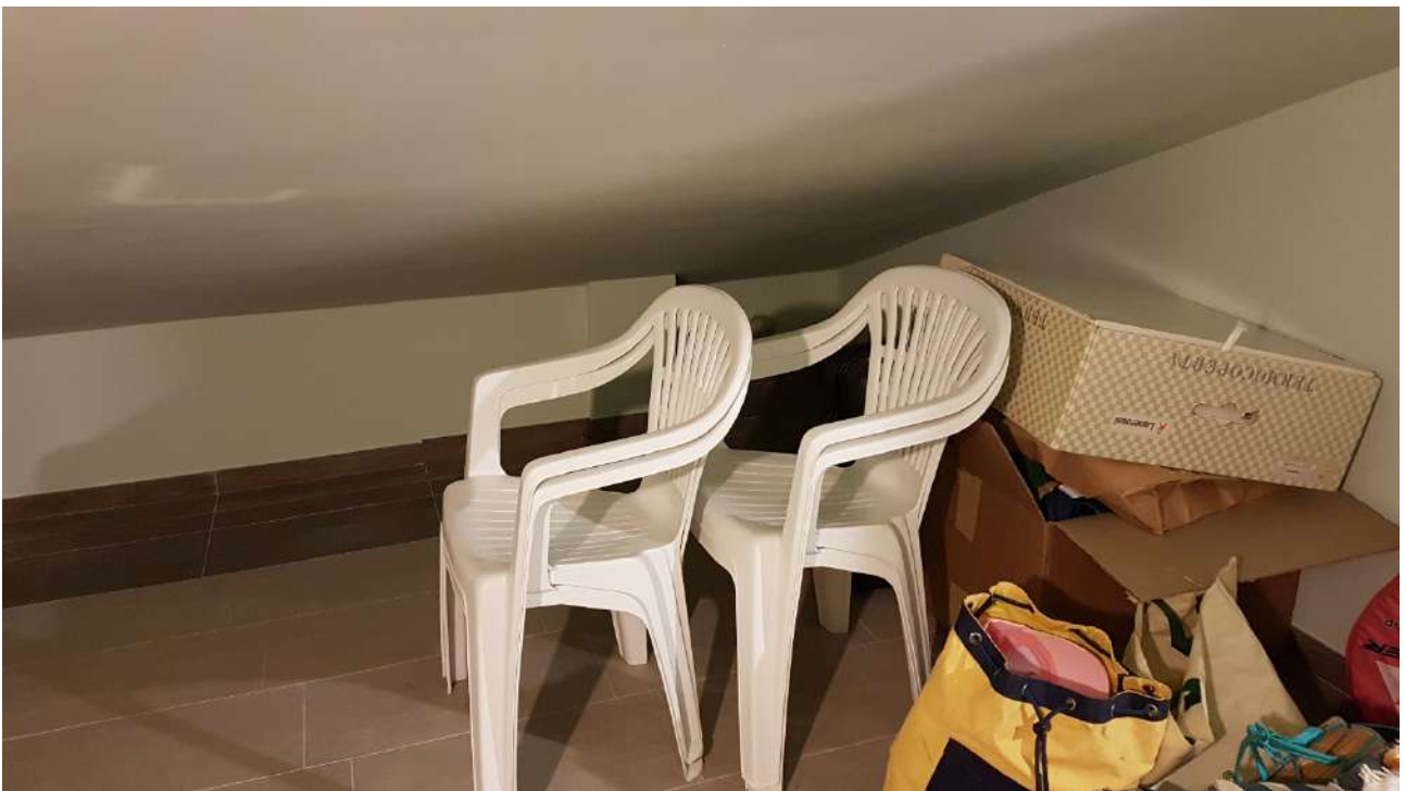
Foto n. 46 - Part. 1177 sub 1 – P. Terzo – Locale di Sgombero
