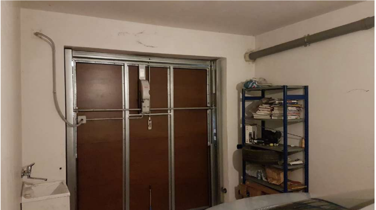
Foto n. 5 - Part. 1177 sub 2 - Autorimessa
