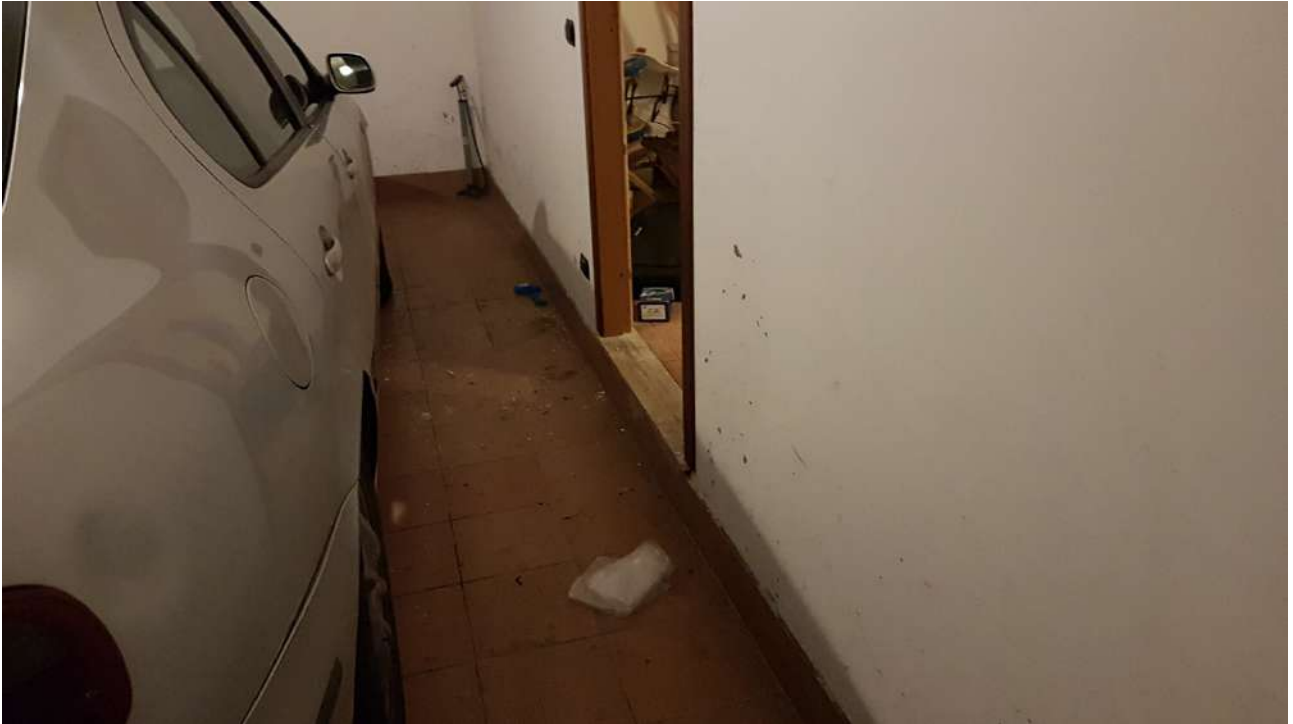
Foto n. 7 - Part. 1177 sub 2 - Autorimessa
