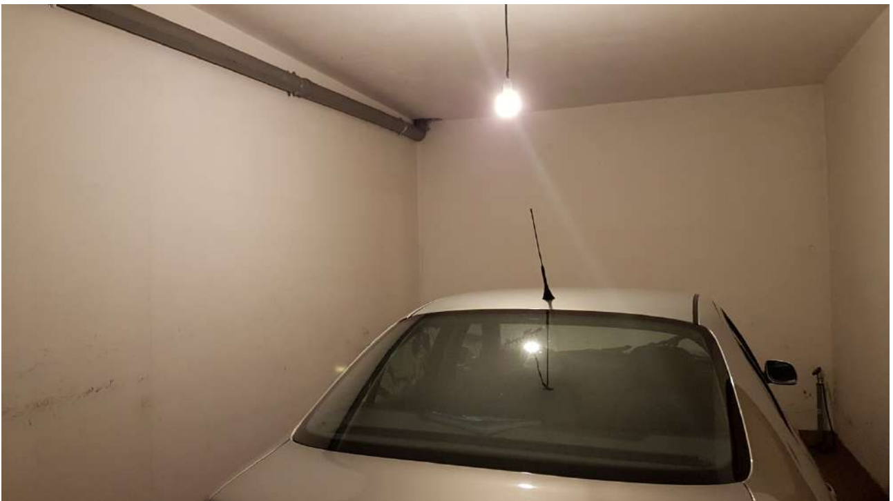
Foto n. 6 - Part. 1177 sub 2 - Autorimessa
