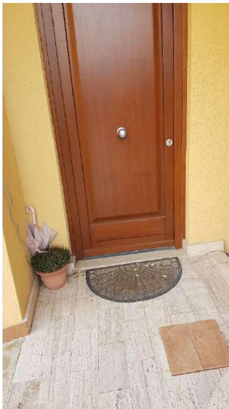
Foto n. 12 – Ingresso principale sub 1 (porzione abitativa)
