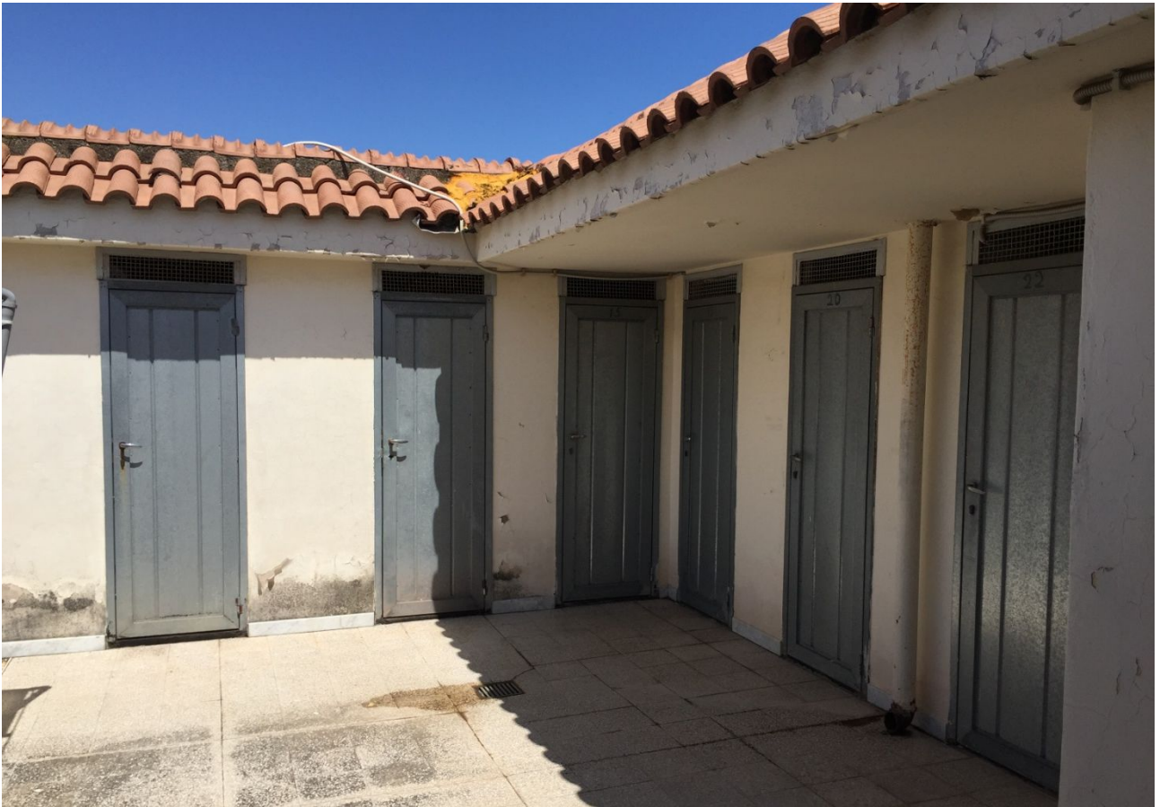
Foto n.8: vista lastrico solare Via Trionfale n.7126
