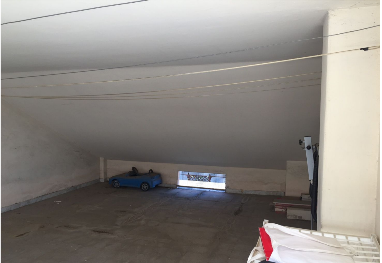
Foto 11: vista lastrico solare Via Trionfale n.7126
