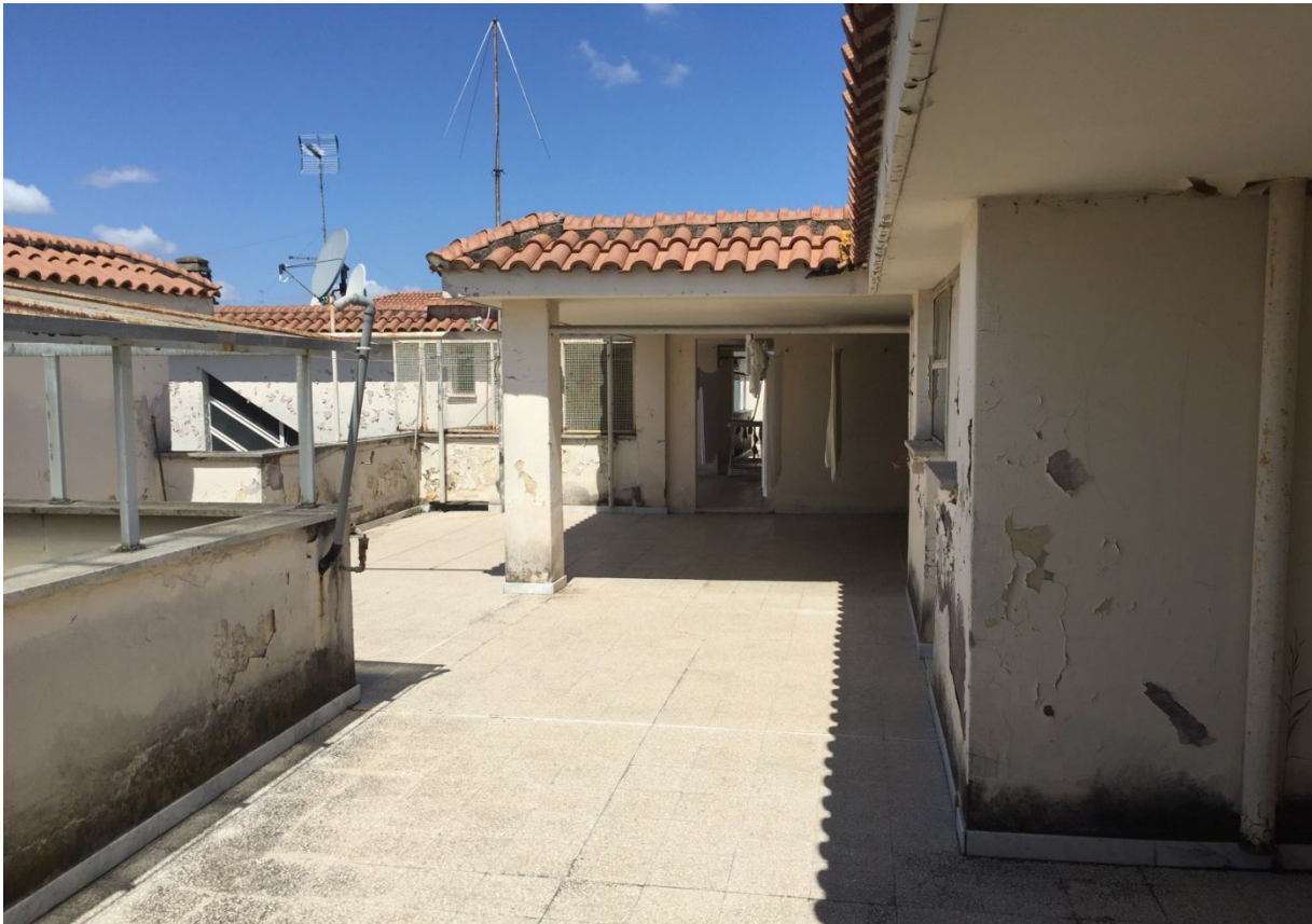
Foto n.5: vista lastrico solare Via Trionfale n.7126
