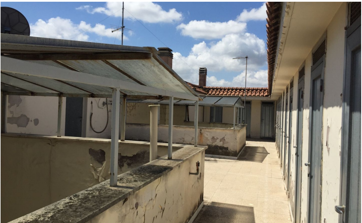
Foto n.10: vista lastrico solare Via Trionfale n.7126
