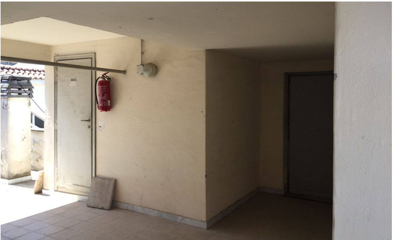
Foto 12: vista lastrico solare Via Trionfale n.7126
