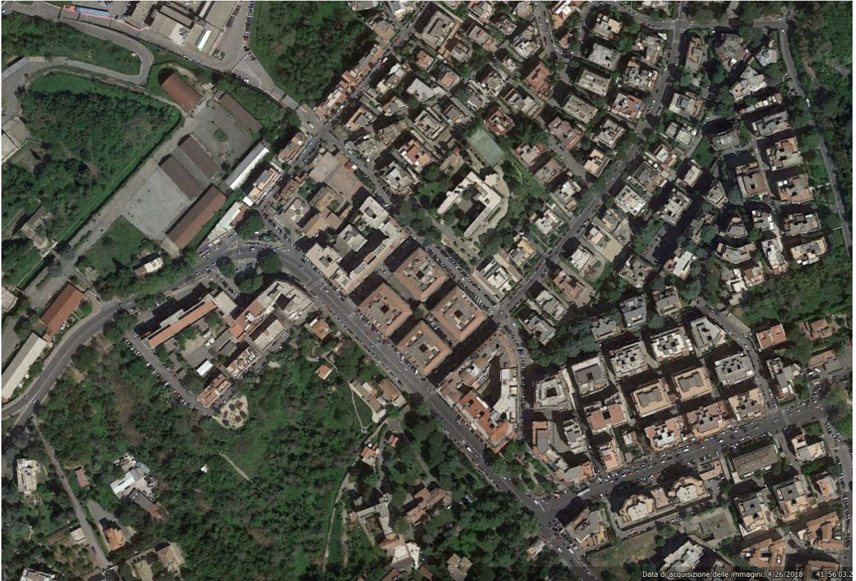
Foto n. 1: Foto aerea - inquadramento dei fabbricati
