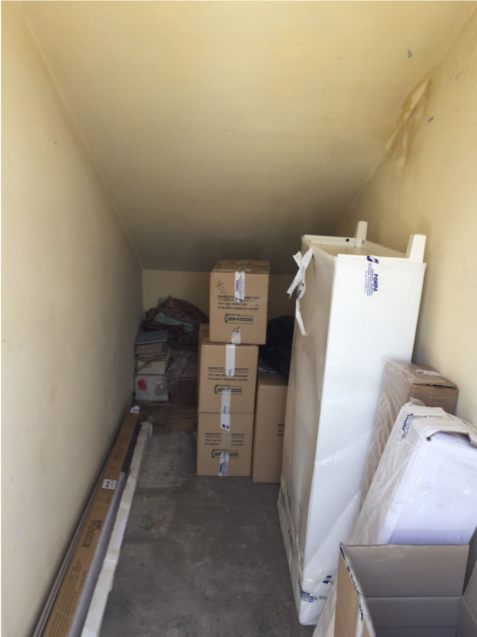
Foto 13: vista interno soffitta tipo
