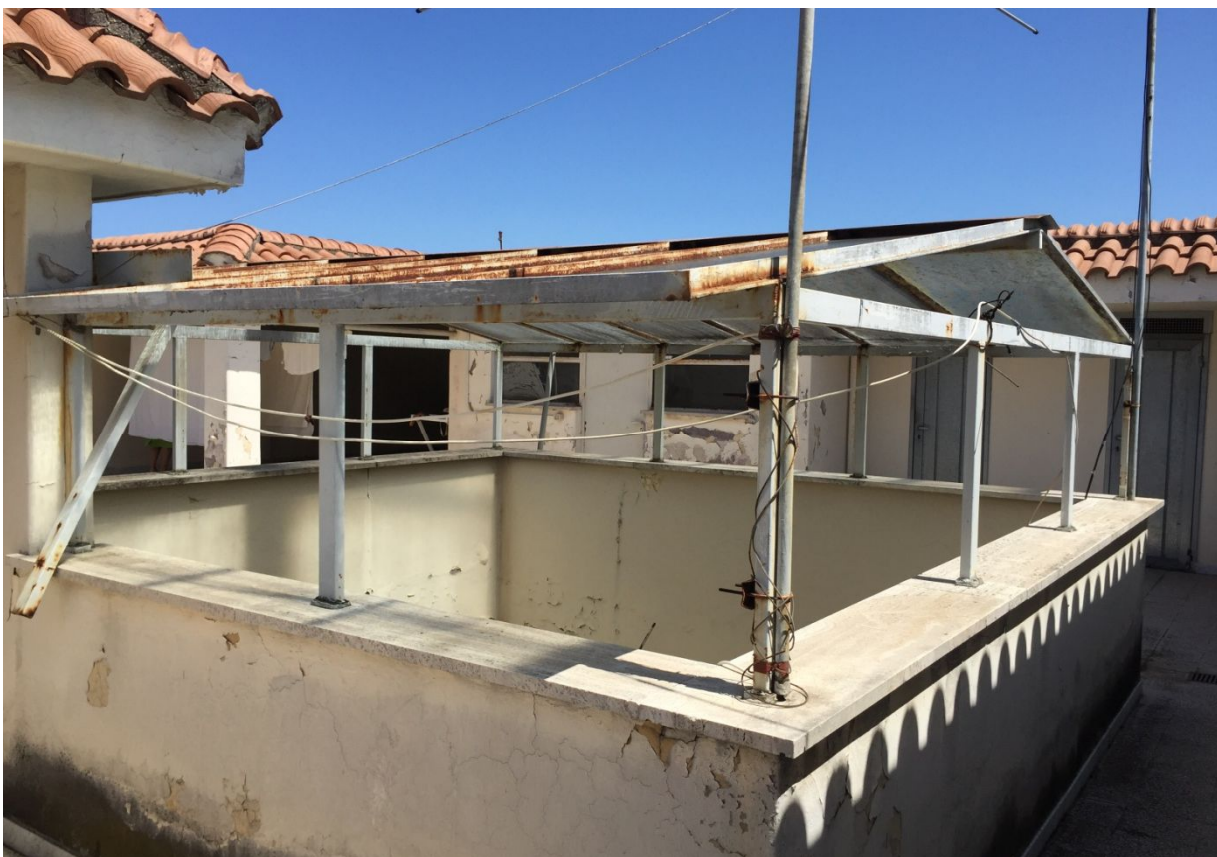
Foto n.6: vista lastrico solare Via Trionfale n.7126
