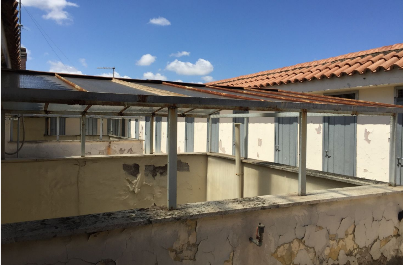
Foto n.7: vista lastrico solare Via Trionfale n.7126
