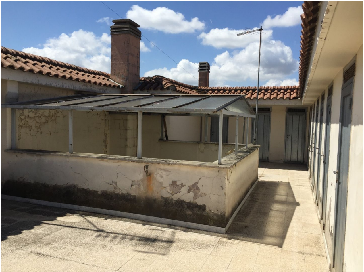
Foto n.9: vista lastrico solare Via Trionfale n.7126
