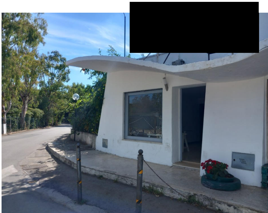
FOTO N. 1 – PROSPETTO PRINCIPALE SU VIA CORNELIA
