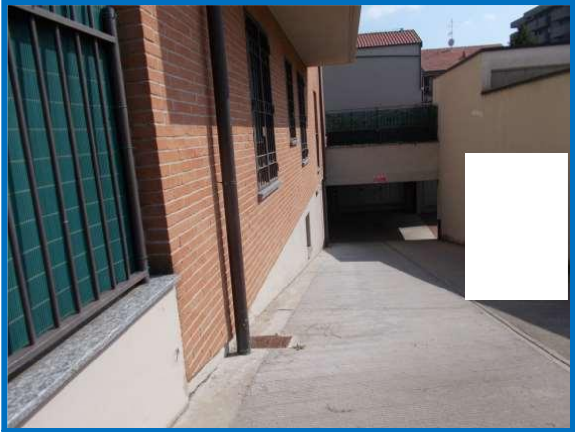
Rampa carrabile verso i box auto interrati
