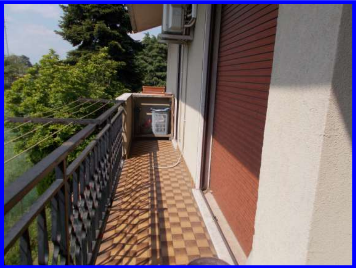
Balcone sul fronte ovest dell'unità immobiliare
