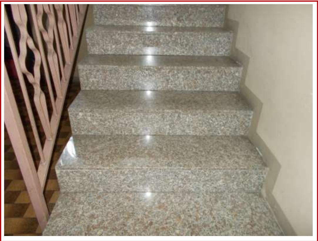
VANO SCALA CONDOMINIALE – RAMPA DAL PIANO S1
