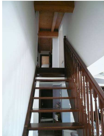
Scala interna di collegamento Tra piano secondo e sottotetto
