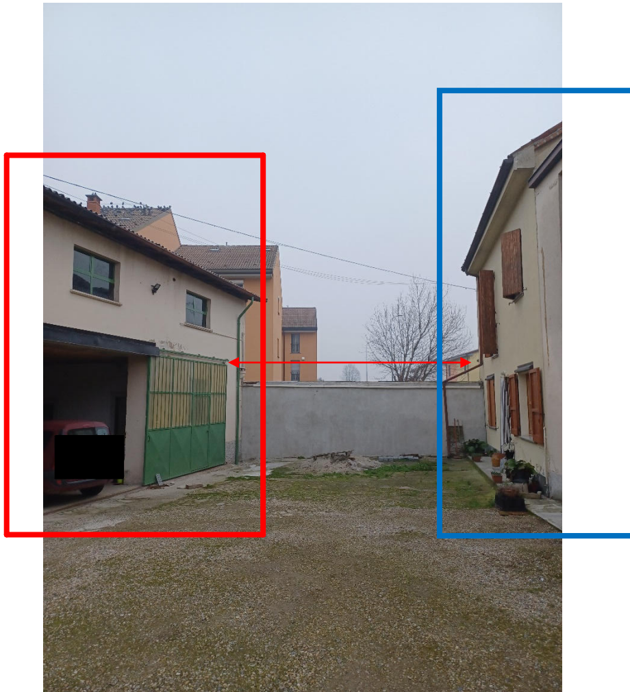
Immagine dei fabbricati accessorio (in colore rosso a sinistra) e abitativo (in colore blu a destra)
