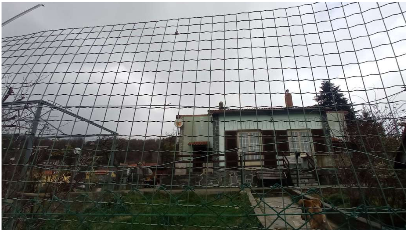
5 - prospetto sud da strada
