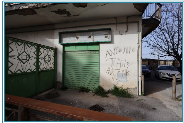
Figura 9 Accesso sul prospetto sud
