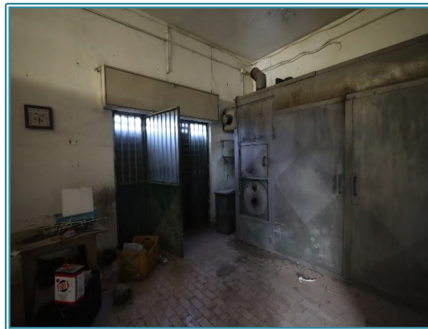
Figura 33 Vista dell'interno del box2
