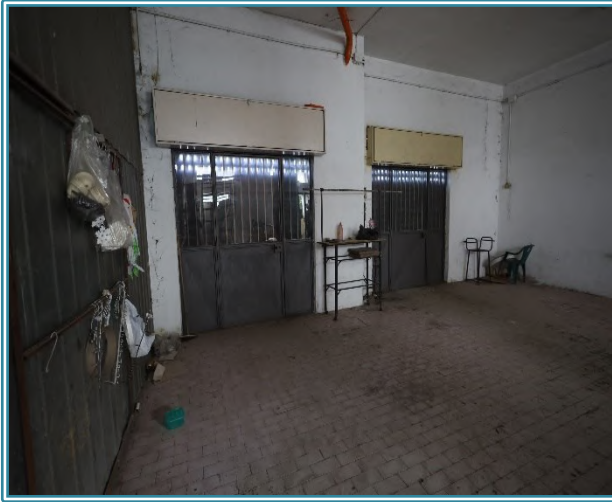
Figura 31 Vista box1 LOTTO 4 fuso con LOTTO 3
