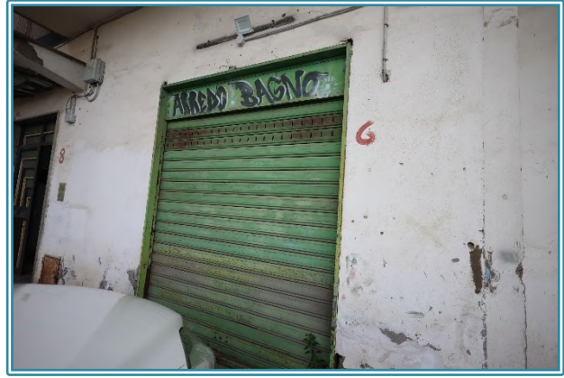
Figura 25 Accesso principale al LOTTO 3
