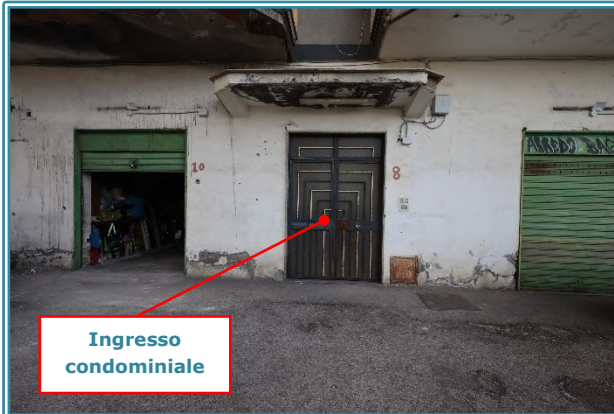
Figura 35 Ingresso condominiale dalla corte comune (sub. 1)
