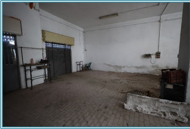
Figura 26 Vista Box LOTTO 3 fuso con LOTTO 4
