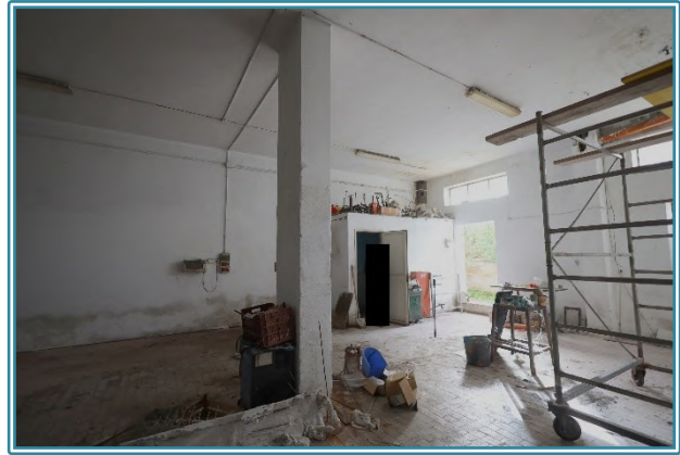
Figura 27 Vista dell'interno del box
