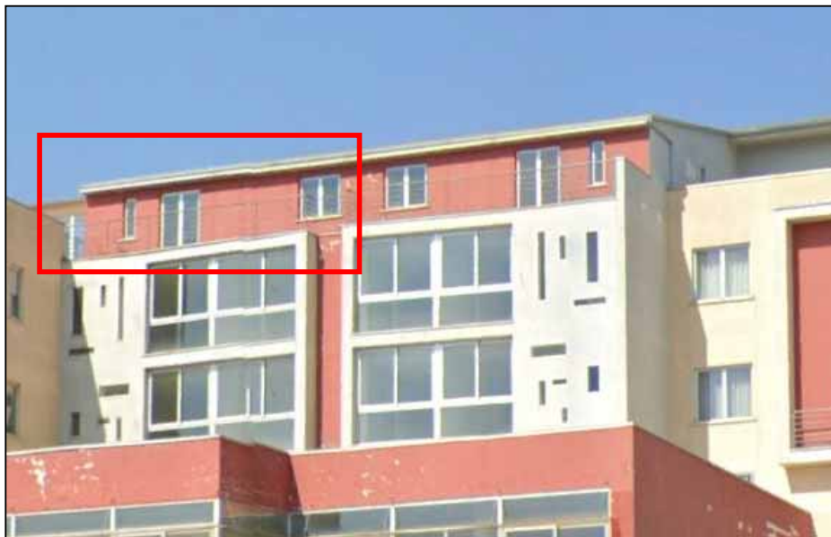
Foto 2 - Prospetto Est del fabbricato con individuazione lotto di vendita al 6° piano
