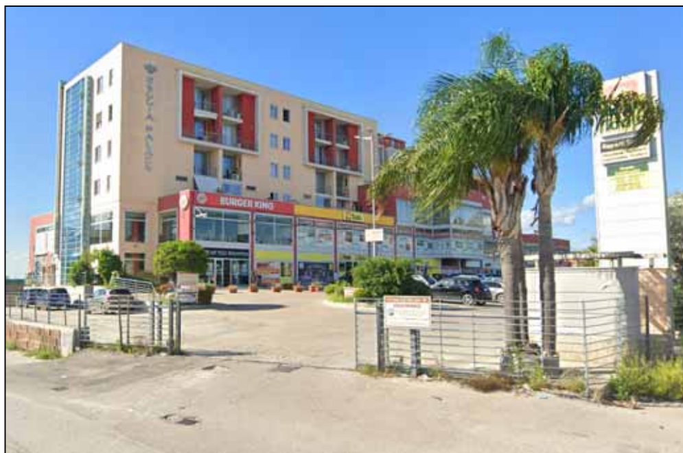
Foto 1 – Il complesso immobiliare “REGGIA PALACE” su viale Carlo III
