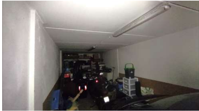
Garage interrato – vista interna
