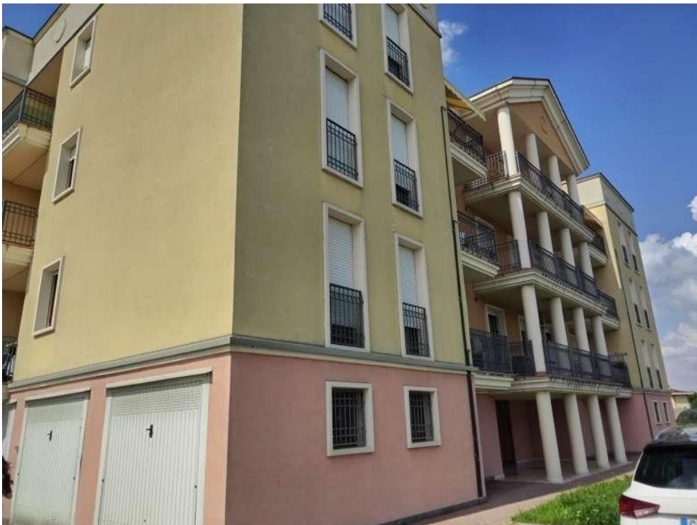
Figura 16. Foto immobili Vista esterna – Prospetto Sud/Ovest
