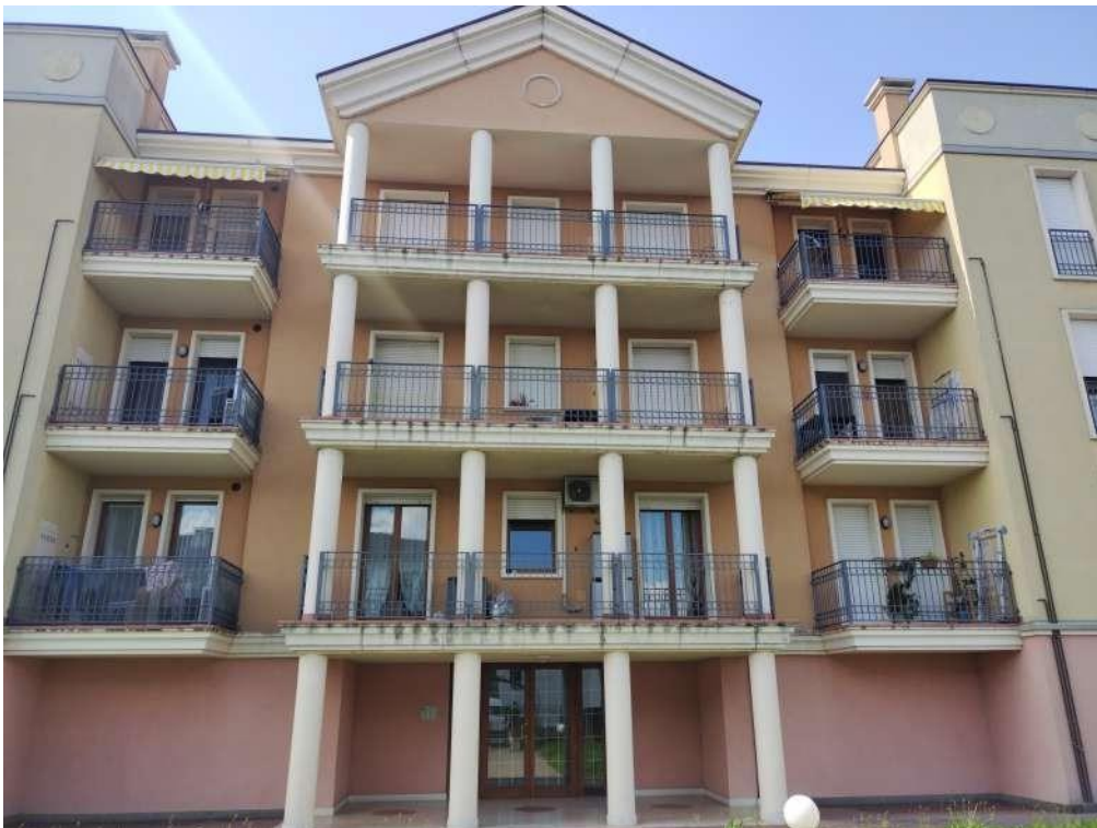
Figura 14. Foto immobili Vista esterna – Prospetto Sud
