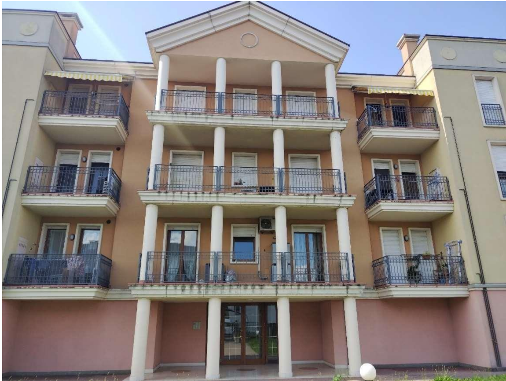
Figura 14. Foto immobili Vista esterna – Prospetto Sud
