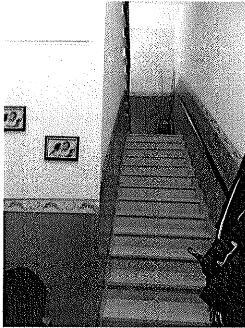
Scala interna di collegamento tra i piani
