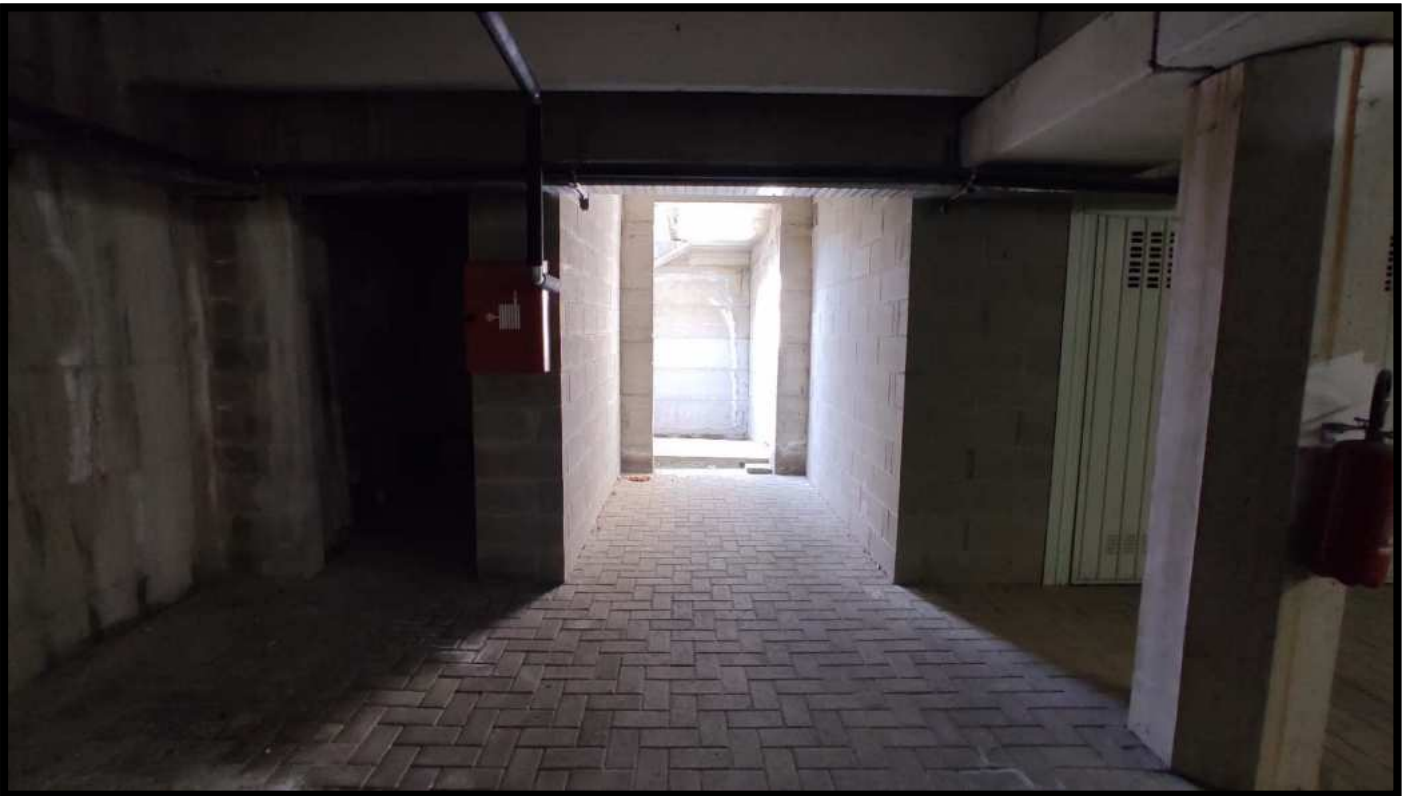
Uscita pedonale piano seminterrato (sub. 731)
